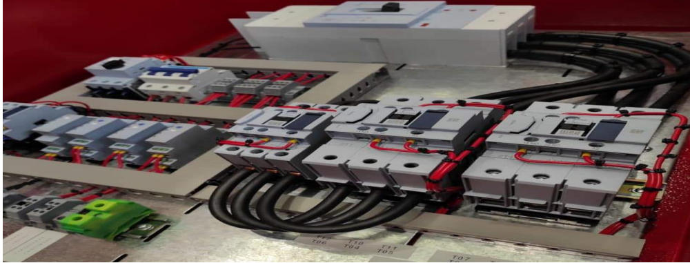
Imagen 6. Contactores marca weg para la automatización de motores.
