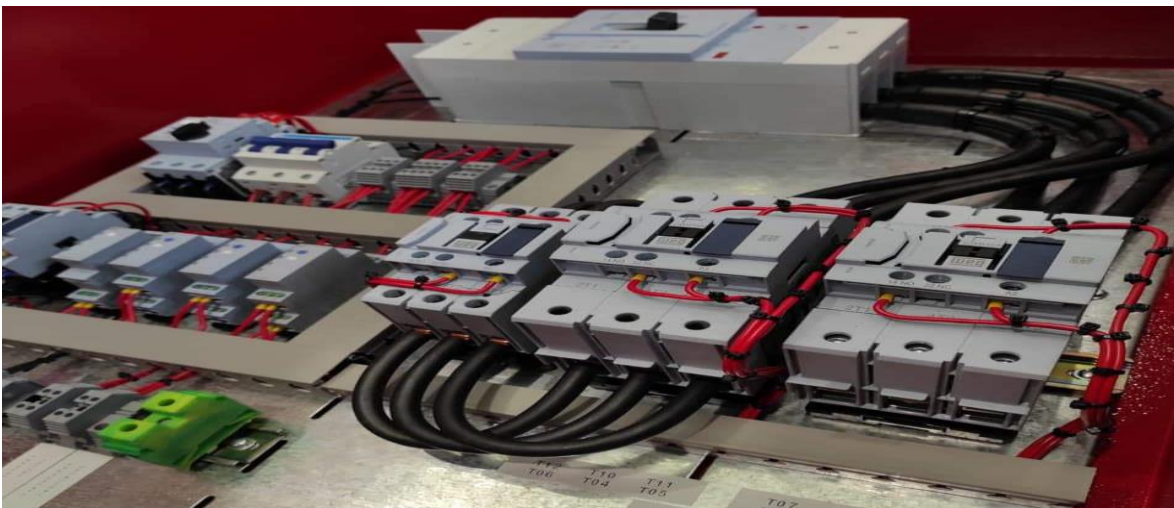
Imagen. Contactores marca weg para la automatización de motores.
