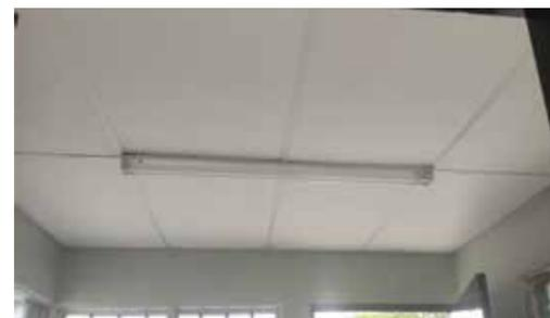
Fotografía 35 Cielo falso Caseta para guarda de seguridad SILAIS Managua Elaboración propia.
