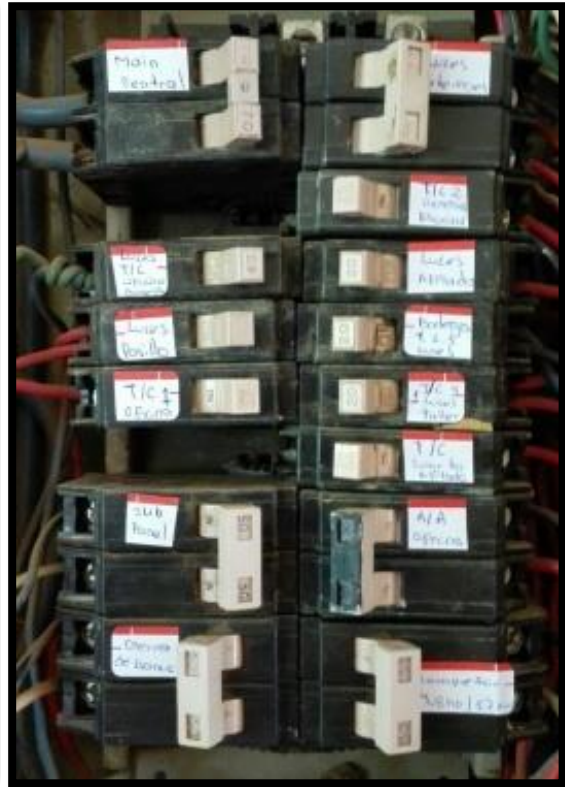
Después de rotulación
