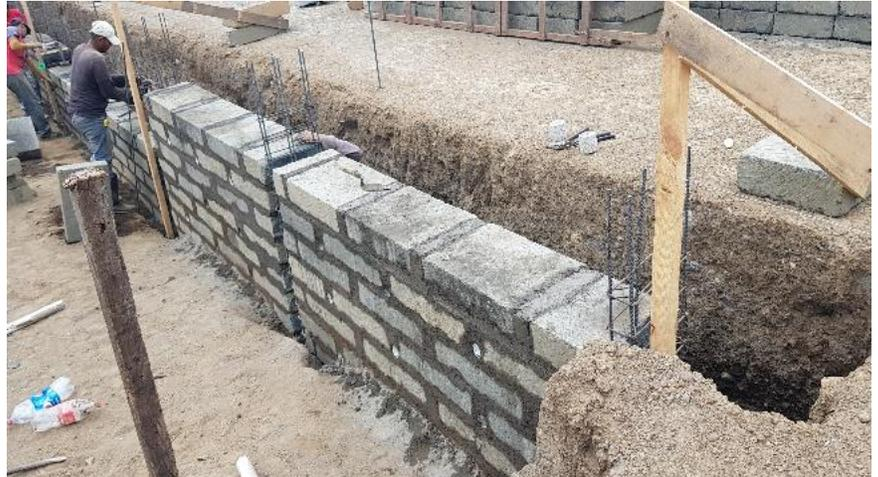
**Nota:** Levantamiento de muro de contención SUR en MO .
