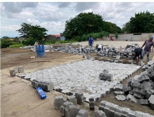
**Nota.** Instalación de Adoquinado.
