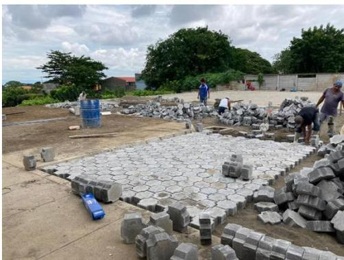
**Nota.** Instalación de Adoquinado.
