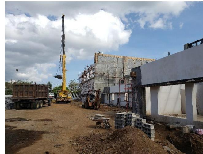
**Ilustración 218: Colocación de gradas por medio de grúa de 75 toneladas de Concretera Total**
