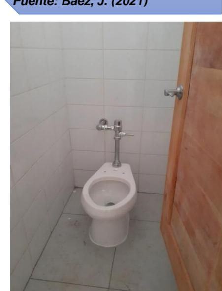
**Ilustración 210: Instalación de inodoros de Fluxometro**
