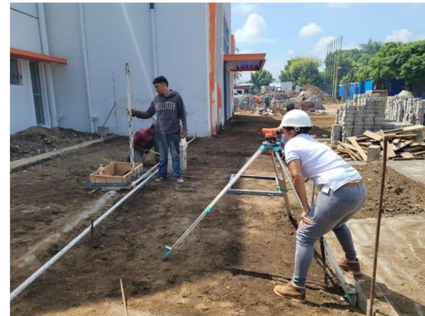
**Ilustración 118:** Proceso de nivelación para el llenado de andenes por medio de teodolito
