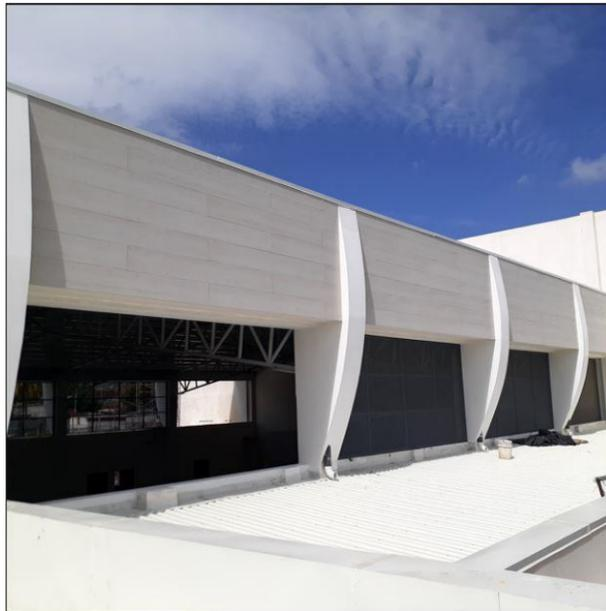
**Ilustración 100: Colocación de láminas de SIDING**
