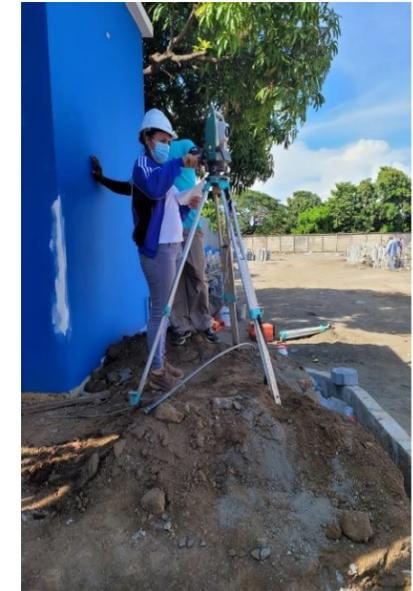
**Ilustración 104: Tirando punto de niveles para calle que se adoquina**
