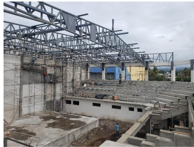
**Ilustración 221: Cercha con refuerzo de platina**
