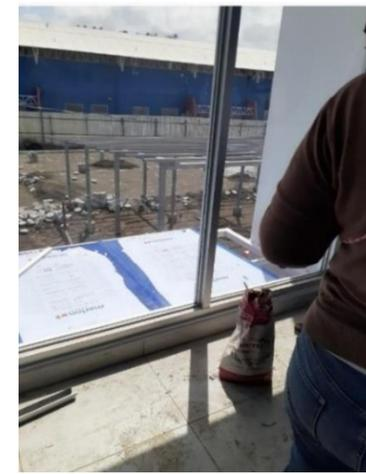
**Ilustración 98: Colocación de marcos de aluminio para ventanas**
