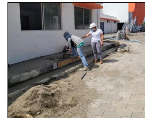
**Ilustración 90: Aplicación del escobillado**
