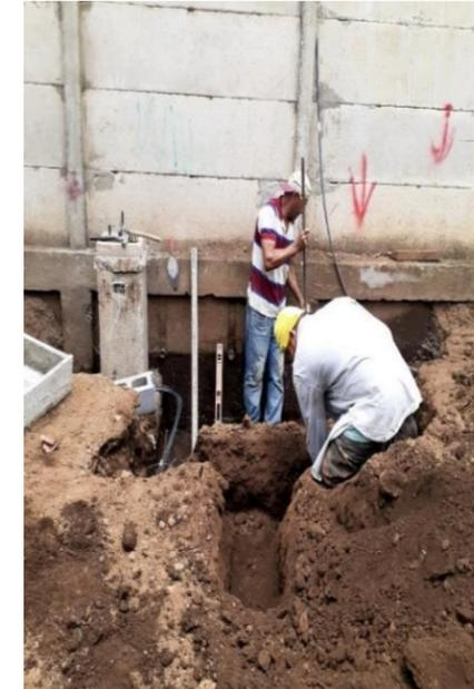
**Ilustración 186: Canalización de alambrado eléctrico**
