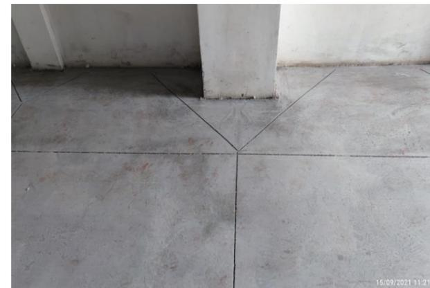
**Ilustración 157:** Diseño de sisa empleada en losa de piso de área de práctica, con el fin de que, si hay fracturas, éstas sean absorbidas por las sisas y se evita su extensión en el Complejo Deportivo Plaza España
