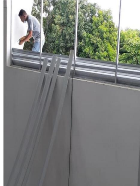
**Ilustración 184: Colocación de louvers en el costado Norte**
