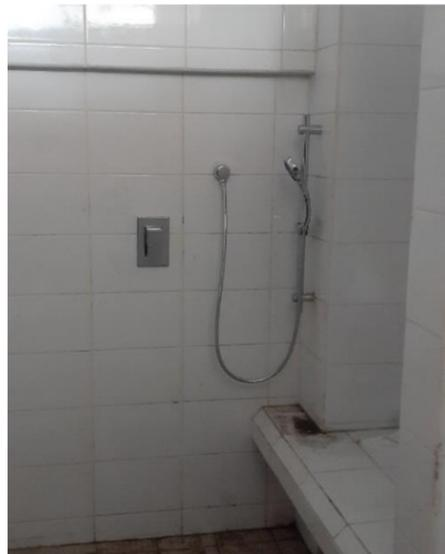
**Ilustración 209: Instalación de regadera con manguera en ducha**
