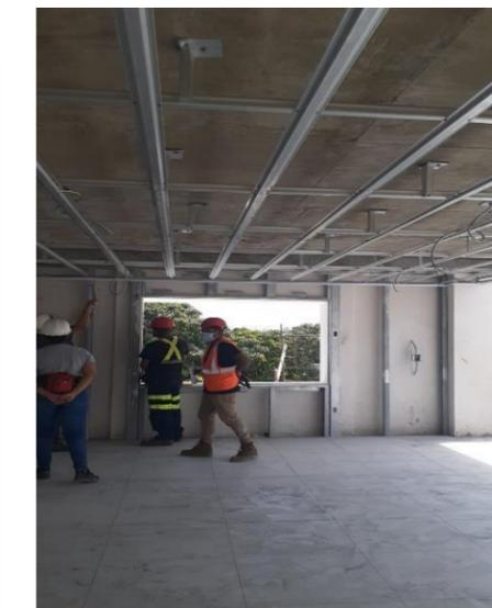
**Ilustración 214: Estructura de aluminio para la colocación de cielo**
