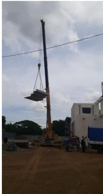
Ilustración 78: Proceso de instalación de gradería con grúa de 100 y 75 toneladas
