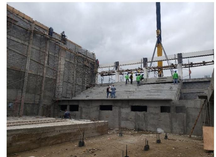
**Ilustración 219: Montaje de grada por medio de grúa de 100 toneladas de Concretera Total**
