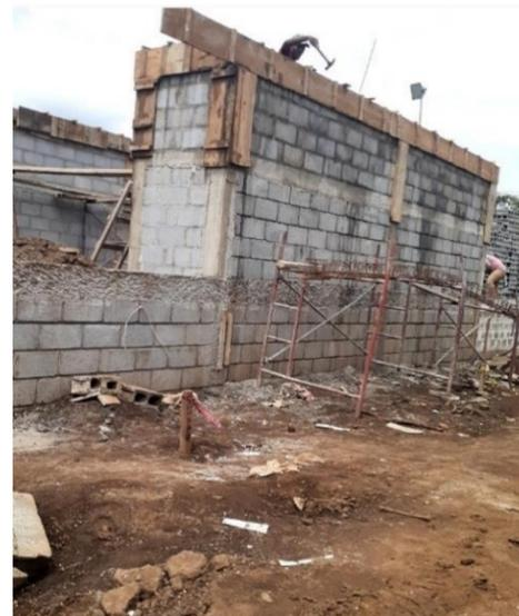
**Ilustración 190: Llenado de viga corona en caseta de generador**
