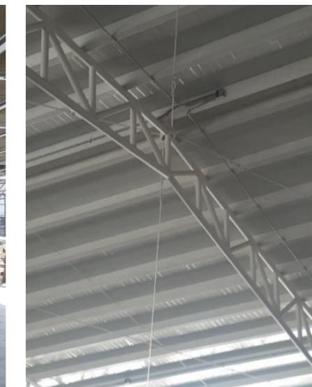
**Ilustración 215: Techo de láminas de THERMO PANEL**
