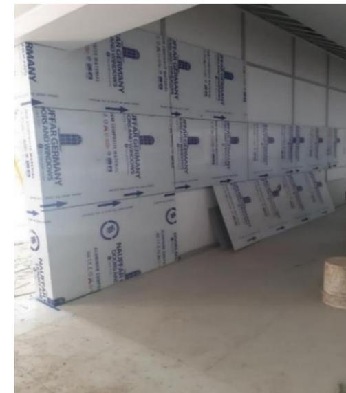
**Ilustración 201:** Colocación de láminas de ACM fijadas con una estructura de aluminio a la pared
