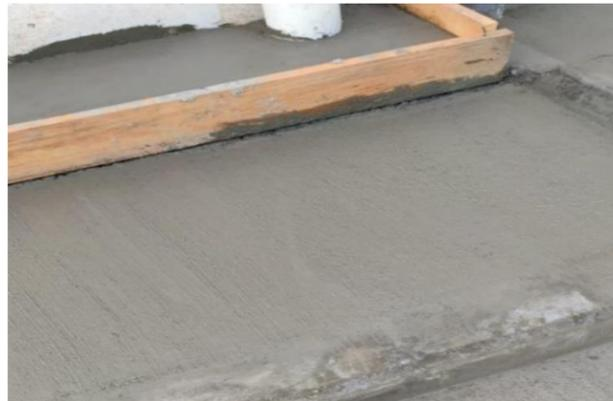
**Ilustración 151:** Reflejando el proceso de escobillado terminado en una parte del andén en Gimnasio Multiusos Plaza España
