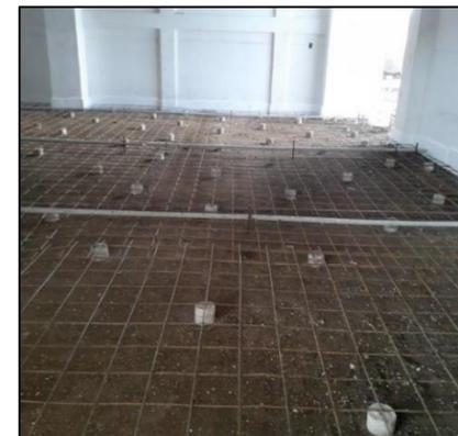
**Ilustración 86: Colocación de parrilla para llenado de losa de piso en área de bodega**
