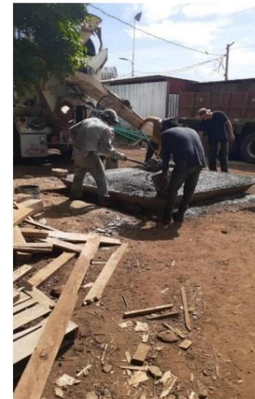
**Ilustración 102: Realizando acarreo para llena de muros**
