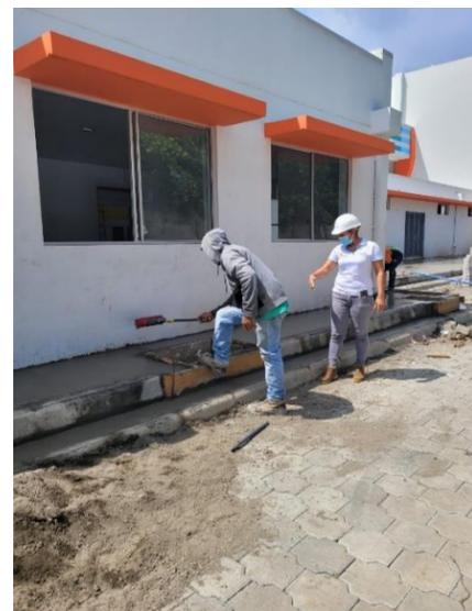
**Ilustración 120:** Proceso de aplicación del escobillado
