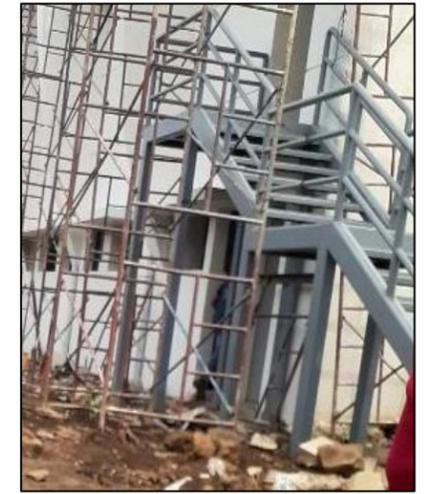
**Ilustración 83: Colocación de escaleras de emergencia Sur**
