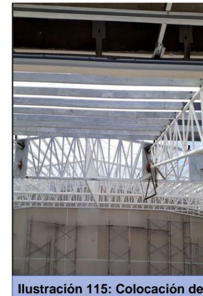
**Ilustración 115:** Colocación de cercha
