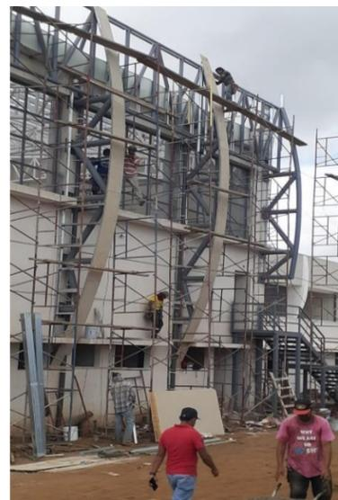
**Ilustración 119:** Forrado de alerones en las fachadas laterales del edificio
