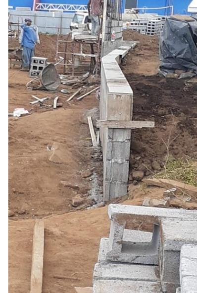
**Ilustración 108:** Muro de contención
