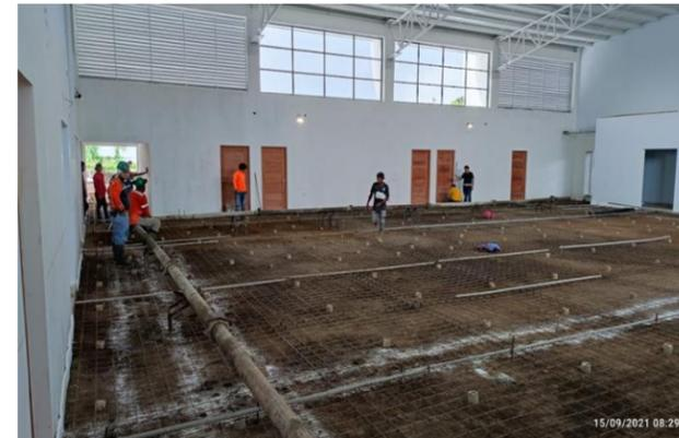
**Ilustración 153:** Instalación de tubos por parte de la empresa contratada Holcim para el llenado de losa de piso en Polideportivo plaza España
