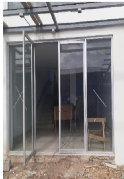
**Ilustración 206: Instalación de puerta de vidrio en costado este de Gimnasio Multiusos de Complejo Deportivo España**
