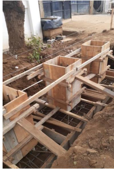
**Ilustración 106:** Armado de formaletas de podio banderas
