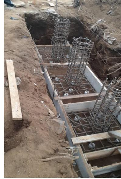
**Ilustración 107:** Armado de acero de zapatas y pedestal
