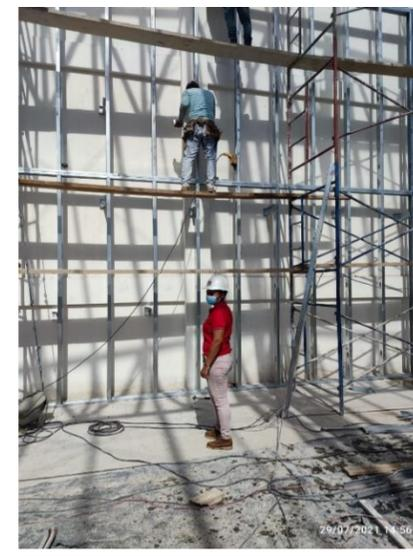
**Ilustración 121:** Supervisión de colocación de estructura y colocación de láminas de PLYCEM en pantalla del área de combates
