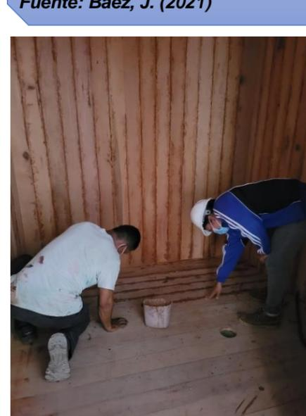
**Ilustración 213: Aplicación de sellador en sauna**
