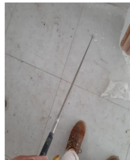
**Ilustración 191: Supervisión de que la cerámica no presente ningún abofamiento por medio de varilla de detección telescópica**
