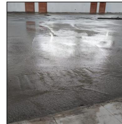
**Ilustración 87: Llenado de losa de piso en área de bodega**
