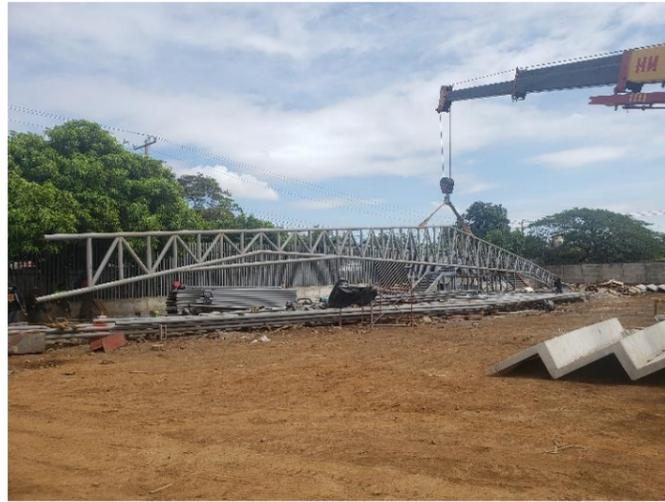
**Ilustración 216: Colocación de cerchas mediante grúa de 75 y 100 toneladas en Gimnasio Multiusos del Complejo Deportivo España**
