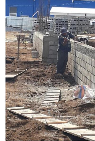
**Ilustración 109:** Elaboración de muro de contención
