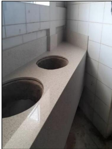
**Ilustración 84: Colocación de granito en los baños**
