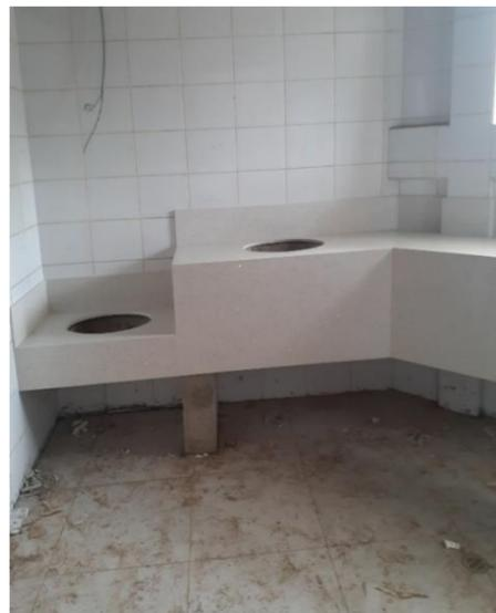
**Ilustración 188: Colocación de faldones de granito en área de lavamanos**
