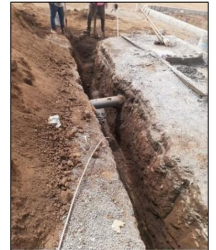
**Ilustración 85: Zanqueo y colocación de tubería hidrosanitaria**
