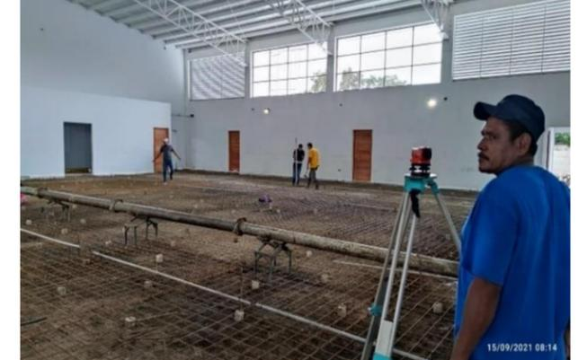
**Ilustración 154:** Comprobación de niveles después de instalación de tubos para llenado de losa por parte de la empresa Holcim en Complejo Deportivo Plaza España
