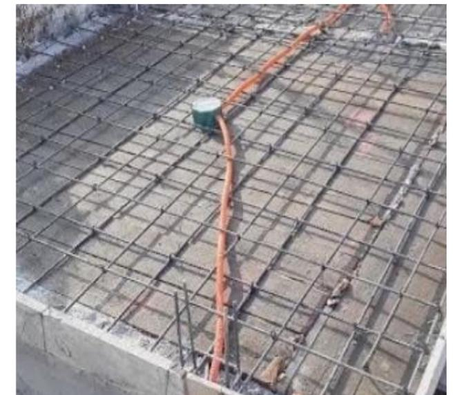
**Ilustración 202:** Colocación de parrilla para el llenado de losa de techo de caseta de guarda de seguridad
