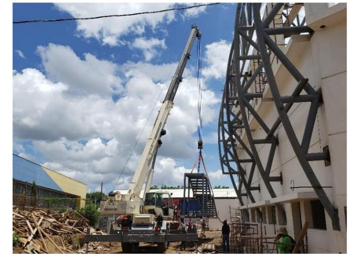
**Ilustración 223: Colocación de escalera de emergencia por medio de grúa de 75 toneladas en Gimnasio Multiusos del Complejo Deportivo España**
