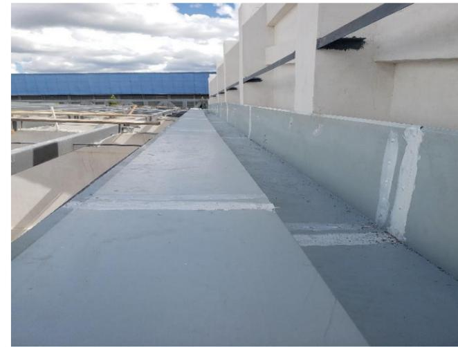
**Ilustración 222: Colocación de refuerzo de FLASHING**
