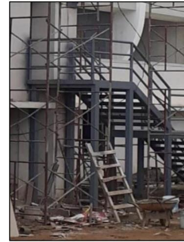
**Ilustración 82: Colocación de escaleras de emergencia Sur**
