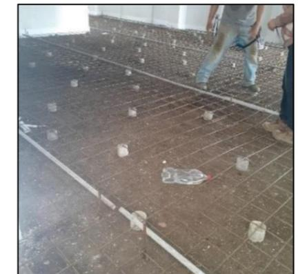
**Ilustración 88: Colocación de parrilla para llenado de losa de piso de área de combate**
