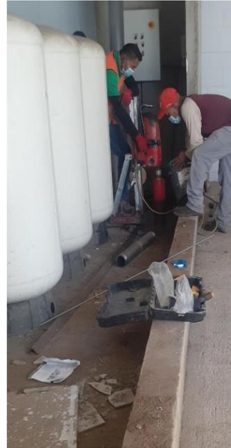
**Ilustración 117:** Se realiza una perforación de losa para una conexión a cisterna existente por medio de máquina perforadora, instalación de tubo que sirva como pase al equipo de bombeo
