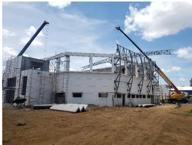
**Ilustración 220: Colocación de cerchas por medio de grúa de Concretera Total de 75 y 100 toneladas en Gimnasio Multiusos del Complejo Deportivo España**
