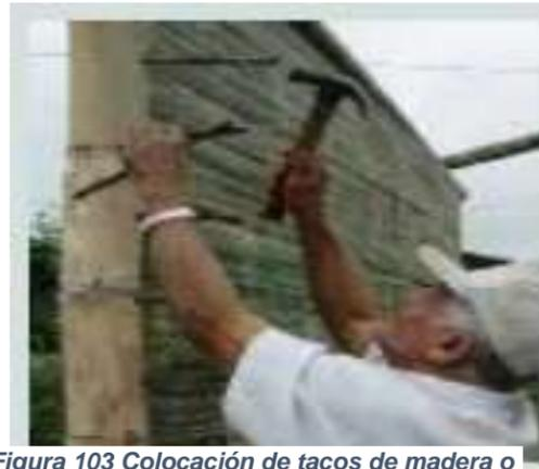
Figura 103 Colocación de tacos de madera o varillas de acero. Fuente: Manual del bambú.
