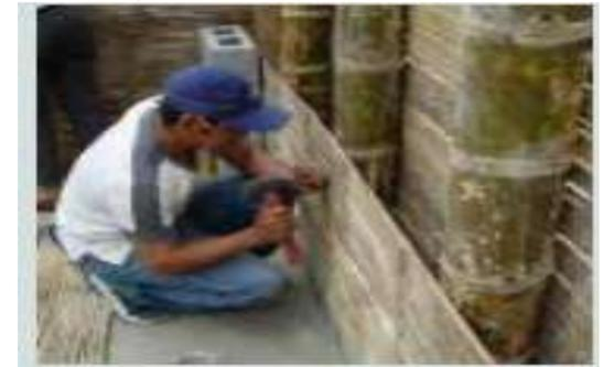
Figura 99 Colocación de maya. Fuente manual del bambú
