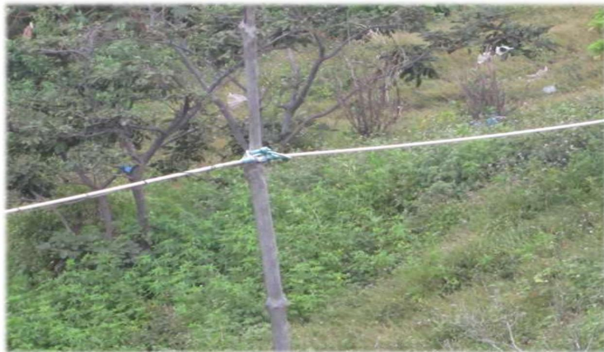
Figura 38: Tuberías de agua potable. Elaboración propia.
