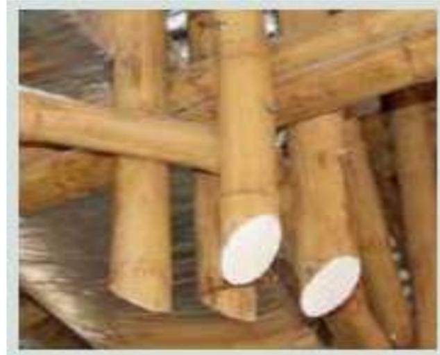
Figura 111 Sellado de cañas de bambú. Fuente: Manual del bambú.
