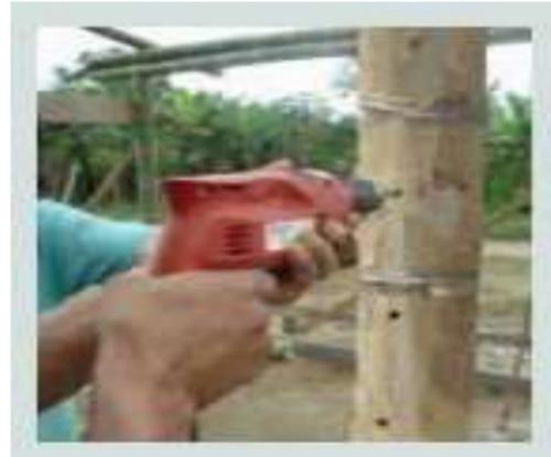
Figura 102 Perforaciones en caña de bambú. Fuente: Manual del bambú.
