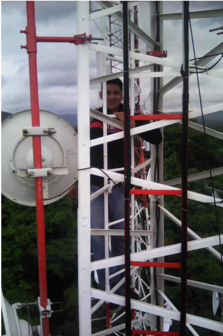
Imagen 5 Alineación Rocket M5
