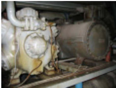
Fig. A-11 Ejemplo de compresor recíprocante.
