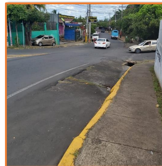
Ilustración 33, entrada a calle Alfonso Monterrey Medina.
