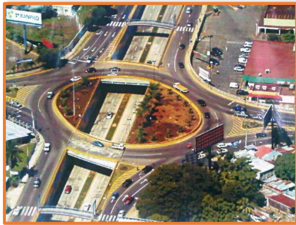
Ilustración 28, construcción finalizada de paso a desnivel rotonda Centroamérica.
