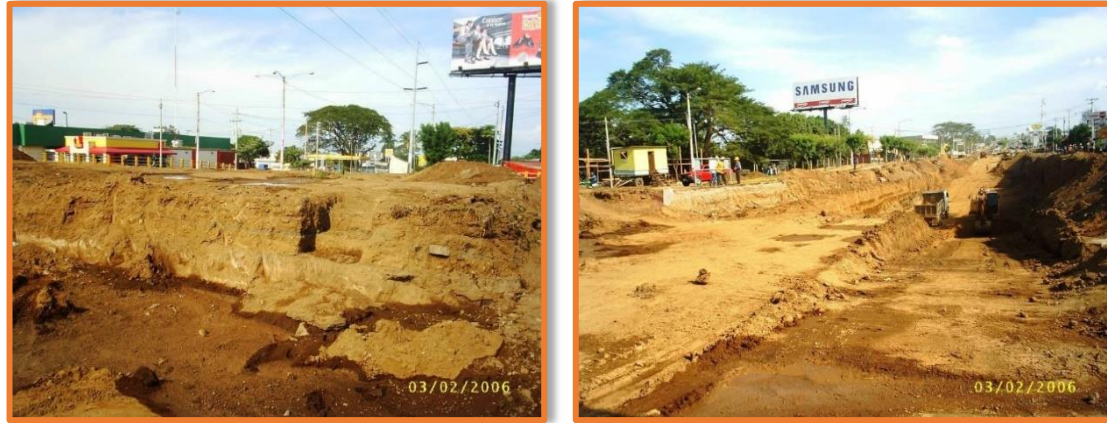
Ilustración 27, excavación para construcción de paso a desnivel rotonda Centroamérica, año 2006.
