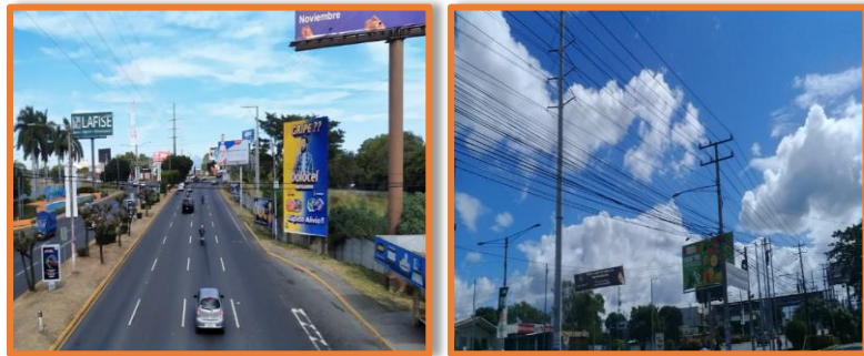
Ilustración 85, contaminación visual por rótulos y cableado eléctrico.
