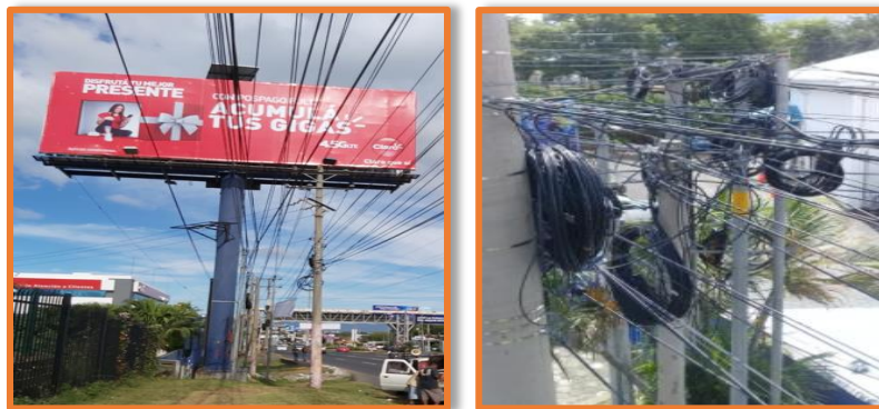
Ilustración 86, contaminación visual por rótulos y cableado eléctrico.
