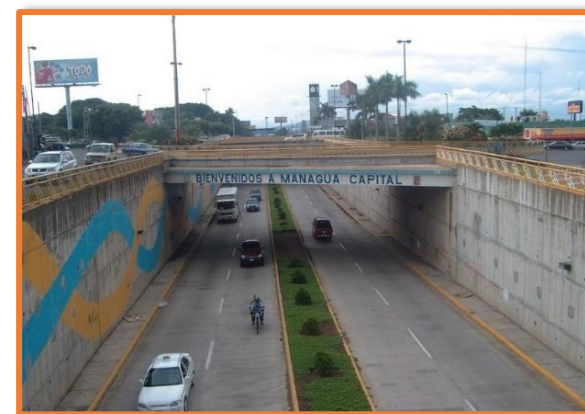
Ilustración 26, Paso a desnivel Colonia Centroamérica.
