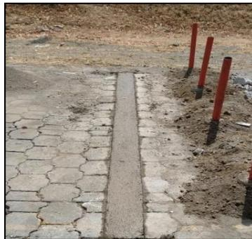
**Foto N° 36:** Viga terminada / Cuido y resguardo de viga de concreto.
