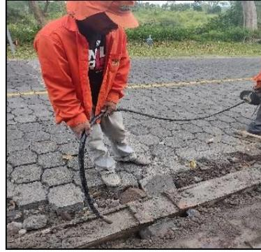
**Foto N° 33:** Vibrado del concreto
