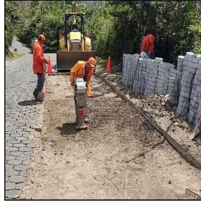
**Foto N° 17:** Compactación y humectación del terreno, previo a la colocación de cama de arena
