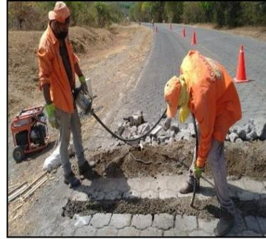
**Foto N° 35:** Vibrado del concreto
