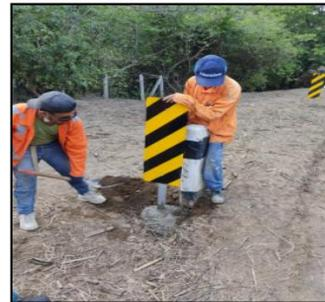
**Foto N° 50:** Colocación de delineador a doble cara.
