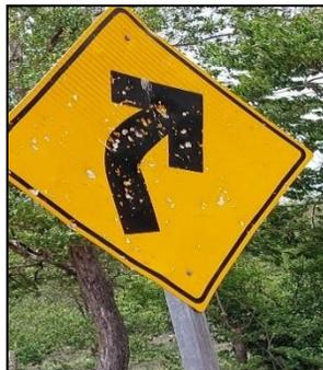
**Foto N°4:** Señal vertical “Curva a la Derecha” con vinil reflectivo deteriorado.
