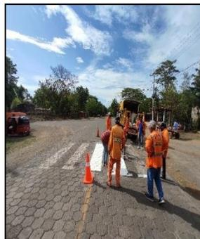
**Foto N° 44:** Aplicación de pintura para simbología de pavimentos.
