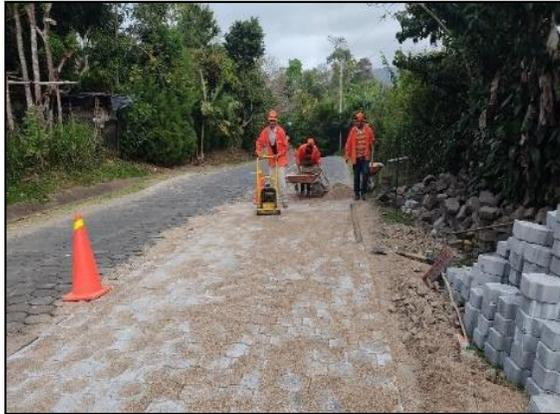
**Foto N° 20:** Utilización de plato vibratorio para sellado de juntas con arena.
