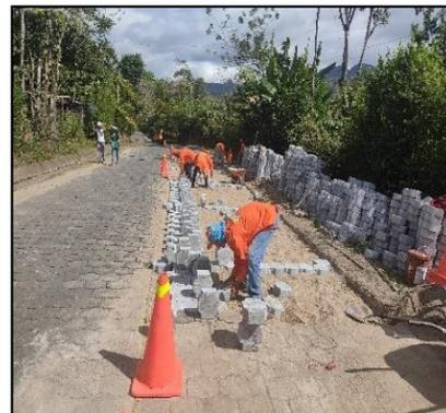
**Foto N° 19:** Colocación de adoquines nuevos.
