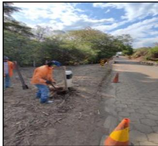
**Foto N° 49:** Zanjeado para colocación de delineador a doble cara.
