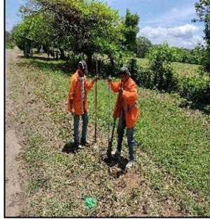
**Foto N° 47:** Zanjeado para colocación de señal vertical.
