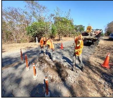
**Foto N° 34:** Demolición de viga existente.
