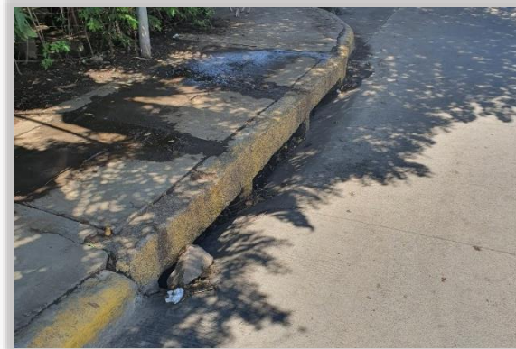
Imagen 6. Tragante esquinero de tipo gaveta, configuración en paralelo (Est 0+323).
