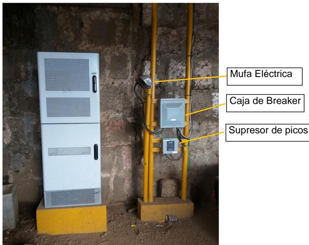
Fig. No. 24 Exterior de los gabinetes Huawei APM30H y gabinete IBBS200D
