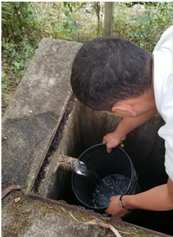
Ilustración 18: Aforo del pozo por el método volumétrico
