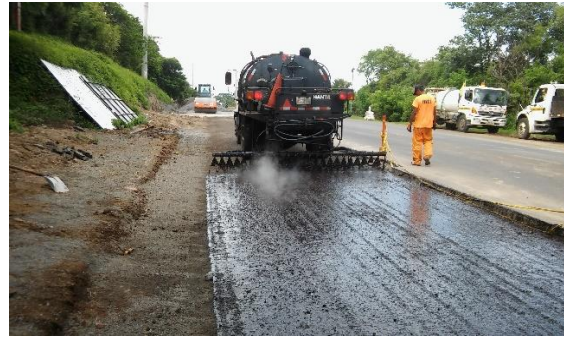
Imagen Imprimación Asfáltica en la Ampliación del Carril derecho (Rotonda Jockey club-semáforos Colegio María Auxiliadora) Acceso Granada.
