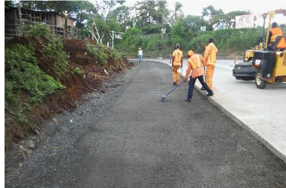
Imagen Imprimación Asfáltica en la Ampliación del Carril derecho (Rotonda Jockey club-semáforos Colegio María Auxiliadora) Acceso Granada.
