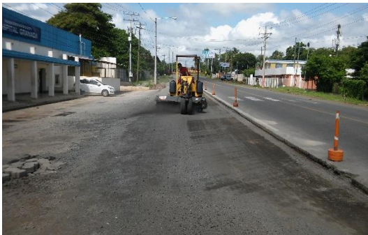
Imagen Imprimación Asfáltica en la Ampliación del Carril derecho (Rotonda Jockey club-semáforos Colegio María Auxiliadora) Acceso Granada.
