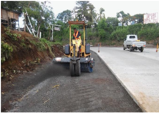
Imagen Imprimación Asfáltica en la Ampliación del Carril derecho (Rotonda Jockey club-semáforos Colegio María Auxiliadora) Acceso Granada.
