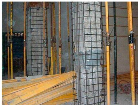
*Ilustración 2-6 - Reforzamiento estructural aplicando el método recrecido de hormigón*
