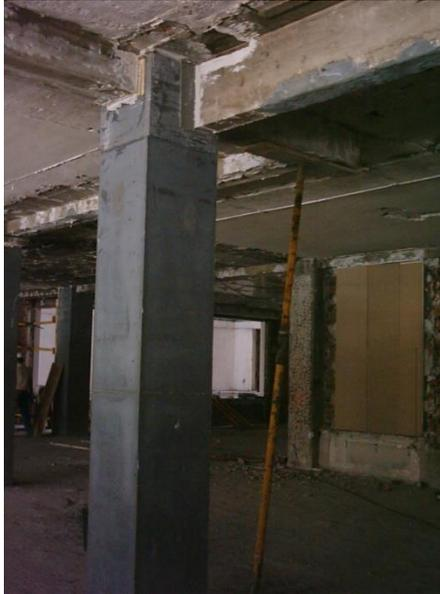
*Ilustración 2-18 - Vaciado y terminación del nuevo elemento, columnas, recrecido de hormigón*
