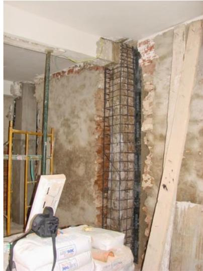
*Ilustración 2-16 - Colocación de reforzamiento longitudinal y transversal, columnas, recrecido de hormigón*
