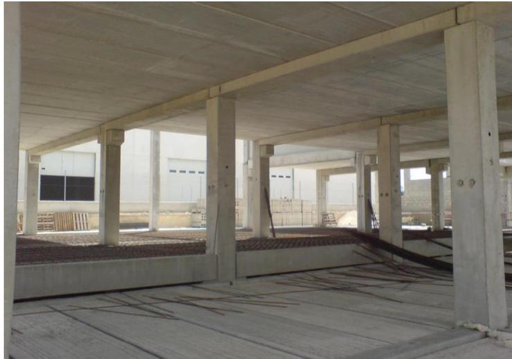
*Ilustración 2-22 - Terminación del elemento, losa, recrecido de hormigón*
