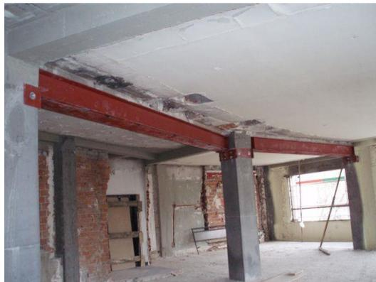
*Ilustración 2-8 - Aplicación de perfiles metálicos para reforzamiento estructural*
