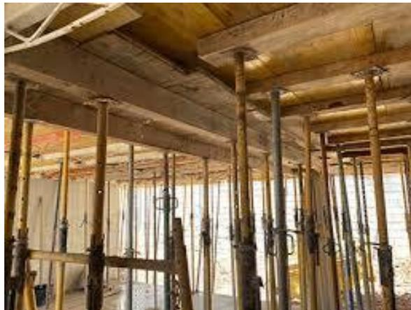
*Ilustración 2-10 - Apuntalamiento para reforzamiento estructural aplicando el método recrecido de hormigón, vigas*
