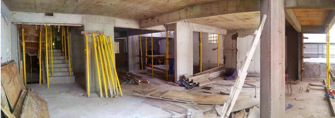
*Ilustración 2-14 - Vaciado y terminación del nuevo elemento, vigas, recrecido de hormigón*
