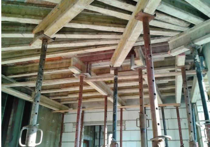
*Ilustración 2-21 - Colocación de encofrado, losas, recrecido de hormigón*
