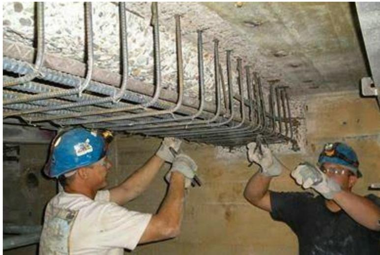
*Ilustración 2-11 - Acero longitudinal y transversal, recrecido de hormigón, vigas*
