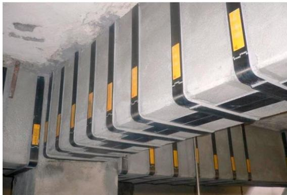
*Ilustración 2-9 - Refuerzo estructural mediante FRP*
