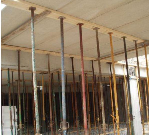
*Ilustración 2-19 - Apuntalamiento, losa, recrido de hormigón*
