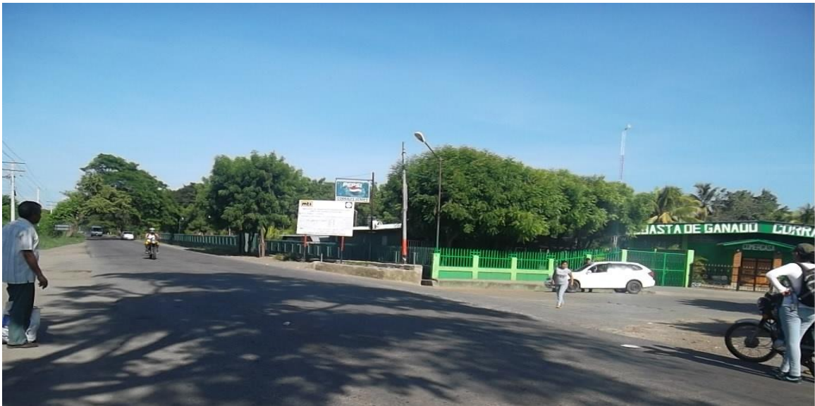
Fotografía 2: Entrada a Cofradía, Est.15+089.
