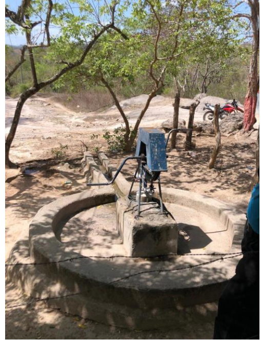
Imagen 5: Pozo existente de 1998
