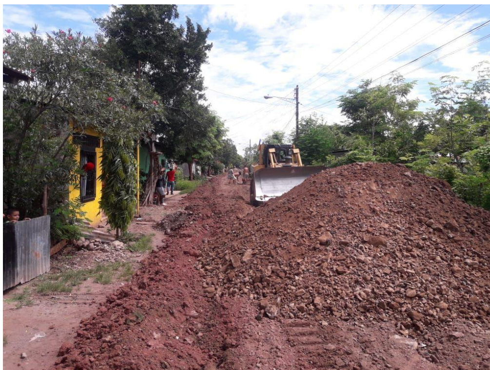
Figura 5. Mantenimiento de calles afectadas por lluvias.
