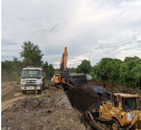
Foto N.º 3 Excavaciones del proyecto
