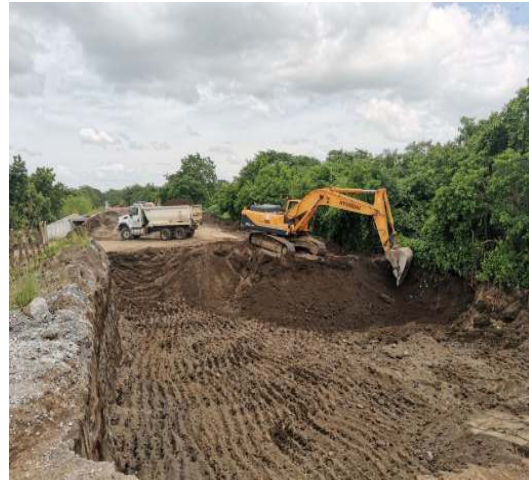
Foto N° 8. Excavaciones de la carretera
