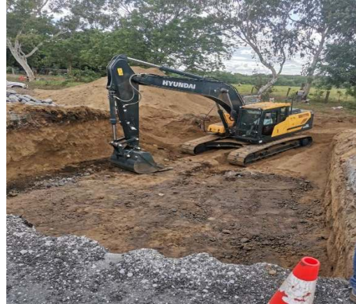
Foto N.º 4 Excavación material selecto
