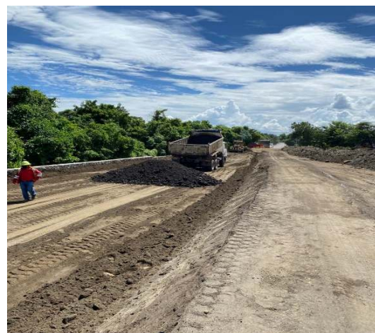
Foto N.º 10. Área de buen drenaje
