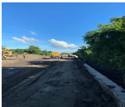
Foto N° 6. Cisterna en proceso de Mitigación del polvo
