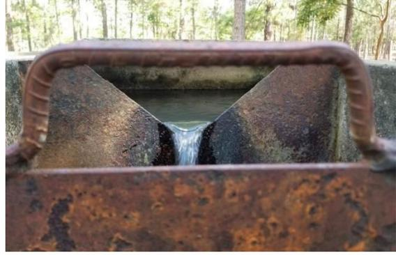
*Detalle del desarenador, sin mantenimiento constante.*
