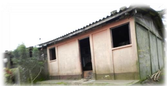
Foto N°17 Fachada De Vivienda
