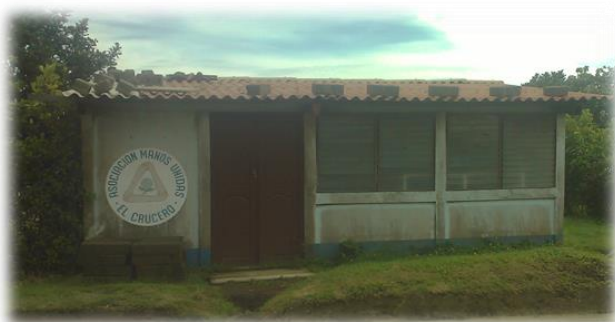
Foto N°20 Fachada De Vivienda
