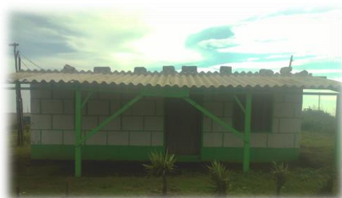
Foto N°18 Fachada De Vivienda
