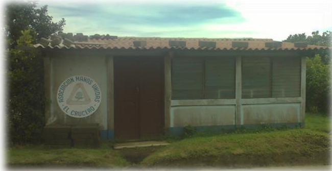
Foto N°22 Fachada De Vivienda
