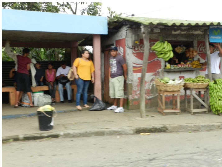
Foto N°28 Estado actual de parada de buses
