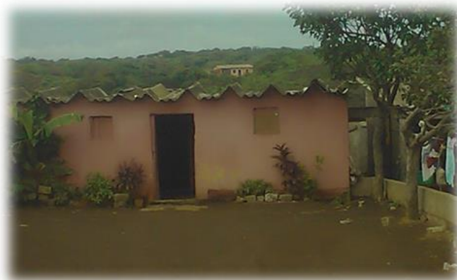
Foto N°21 Fachada De Vivienda
