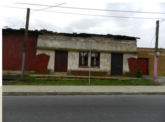
Foto N°24 Estado actual de vivienda
