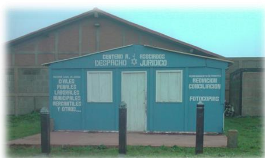
Foto N°21 Fachada De Vivienda
