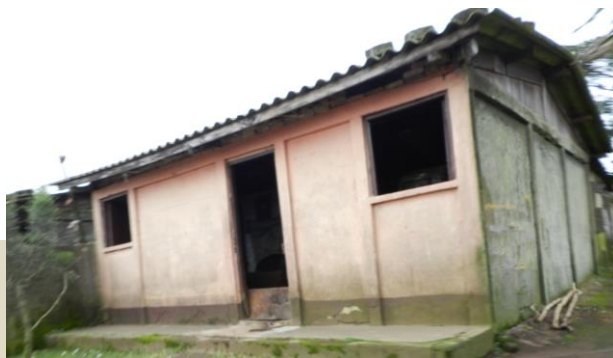
Foto N°25 Estado actual de vivienda
