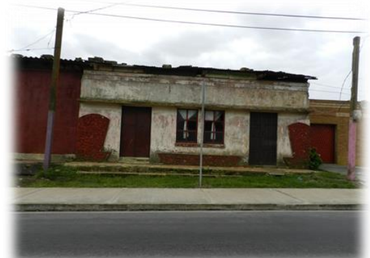
Foto N°23 Fachada De Vivienda
