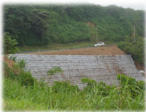
Foto N°5 Talud para evitar derrumbes
