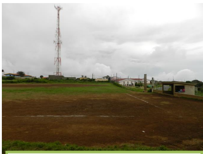
Foto N°28 Estado actual de estadio de beisból
