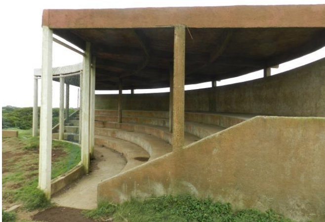
Foto N°29 Estado actual de estadio de beisból
