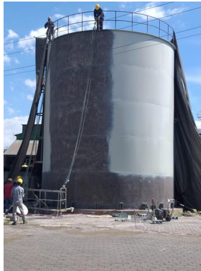
Figura 12: Tanque en proceso de sandblasting (gris claro zona ya tratada)
