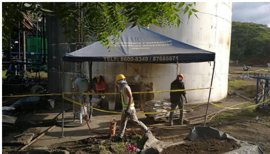
Figura 61: Ejemplo de trabajo cerrado en exteriores (caso de limpieza de tanque)
