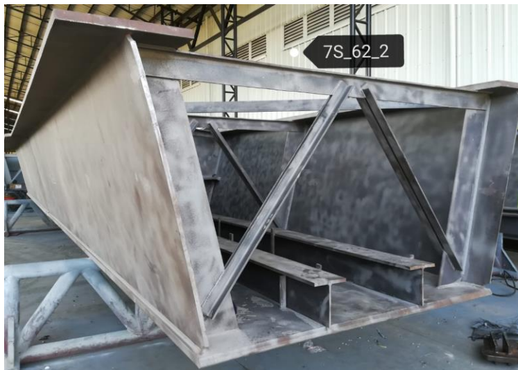
Figura 15: Viga en proceso de limpieza
