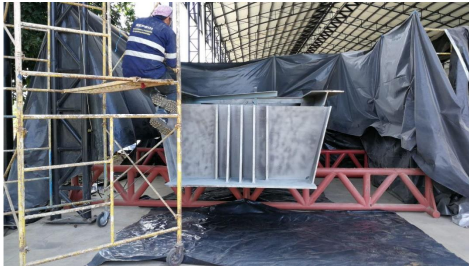
Figura 62: Caso de cerramiento con plástico (limpieza de viga)
