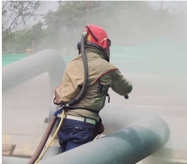
Figura 58: Operador en chorreado (ver polvo adyacente)
