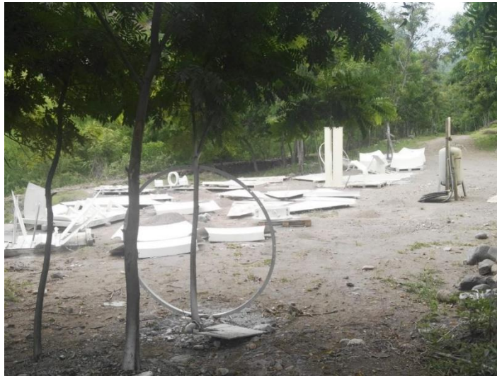
Figura 53: Piezas trasladadas a sitio para aplicación de sandblasting
