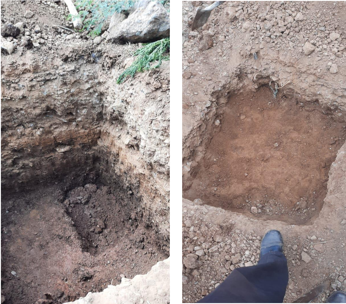
Imagen 6 Excavación y extracción de muestra de sondeo 1 estacion 0+000
