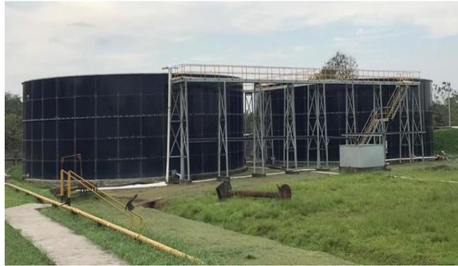
Los tanques ejercen su función para cualquier eventualidad por aumento de caudal, también cuentan con una válvula de salida de agua en la parte inferior de estos, los cuales están conectados entre sí. Una sola tubería conecta la salida de ambos tanques para verter el agua almacenada en ellos a la laguna anaerobia número cuatro (que es parte de la siguiente fase), ver figura 17.
