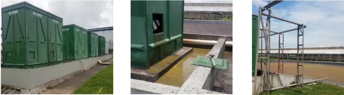
En la siguiente fase consta de tres lagunas de homogenización en serie y dos tanques de decantación, los tiempos de retención en las lagunas es variable considerando el afluente de entrada, así como, el volumen con el que se cuenta. En todas las lagunas se considera un borde libre 0.5 m por cualquier eventualidad climática, ver figura 16.
