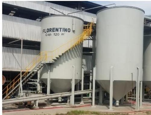
Lo que sedimenta en la parte inferior (cónica) de los tanques es lo que se envía a la siguiente fase, con ayuda de dos bombas de marca KEWPUMP, tipo KS-SE3 con una potencia SEK-80 HP(m<sup>3</sup>/h), ya que debido a la ubicación y diseño de la planta industrial no es posible transportar el POME, por gravedad, en esta fase es donde se remueve la mayor cantidad de grasas y natas de todo el sistema, actuando de esta manera como pretratamiento.
