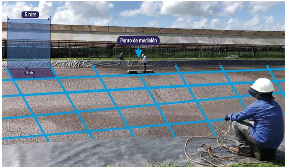
En la figura 5, 6 y 7 se observa el procedimiento para poder determinar la profundidad de los lodos que es resultado de la biodegradación de la materia orgánica y otros productos de síntesis celular. En cuestiones de funcionamiento: la batimetría consiste en la medición de los niveles de lodos y profundidad, en puntos específicos de cada laguna.
