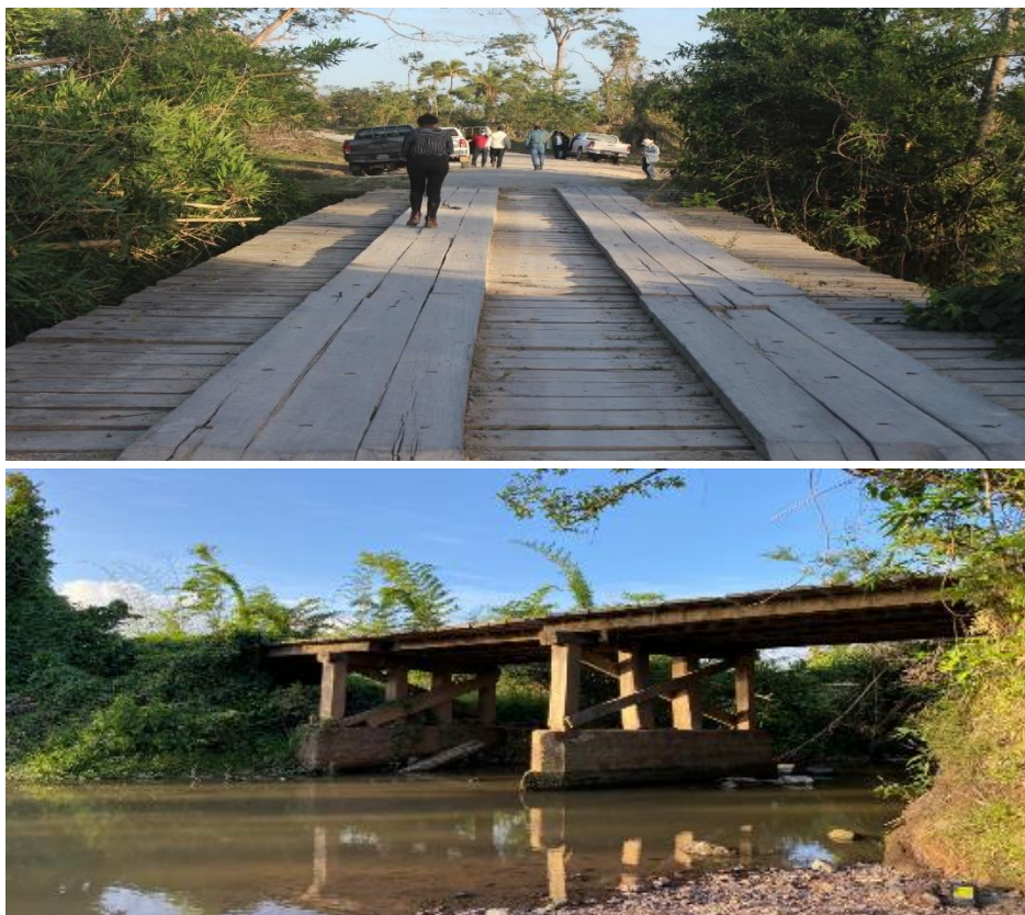
Figura 4. Fotos del puente Kuhu Awala.
