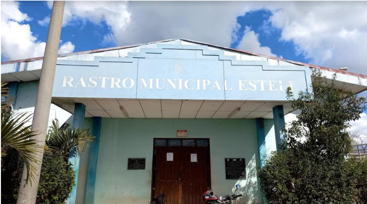
Ilustración 7: Entrada de la planta del rastro municipal.
