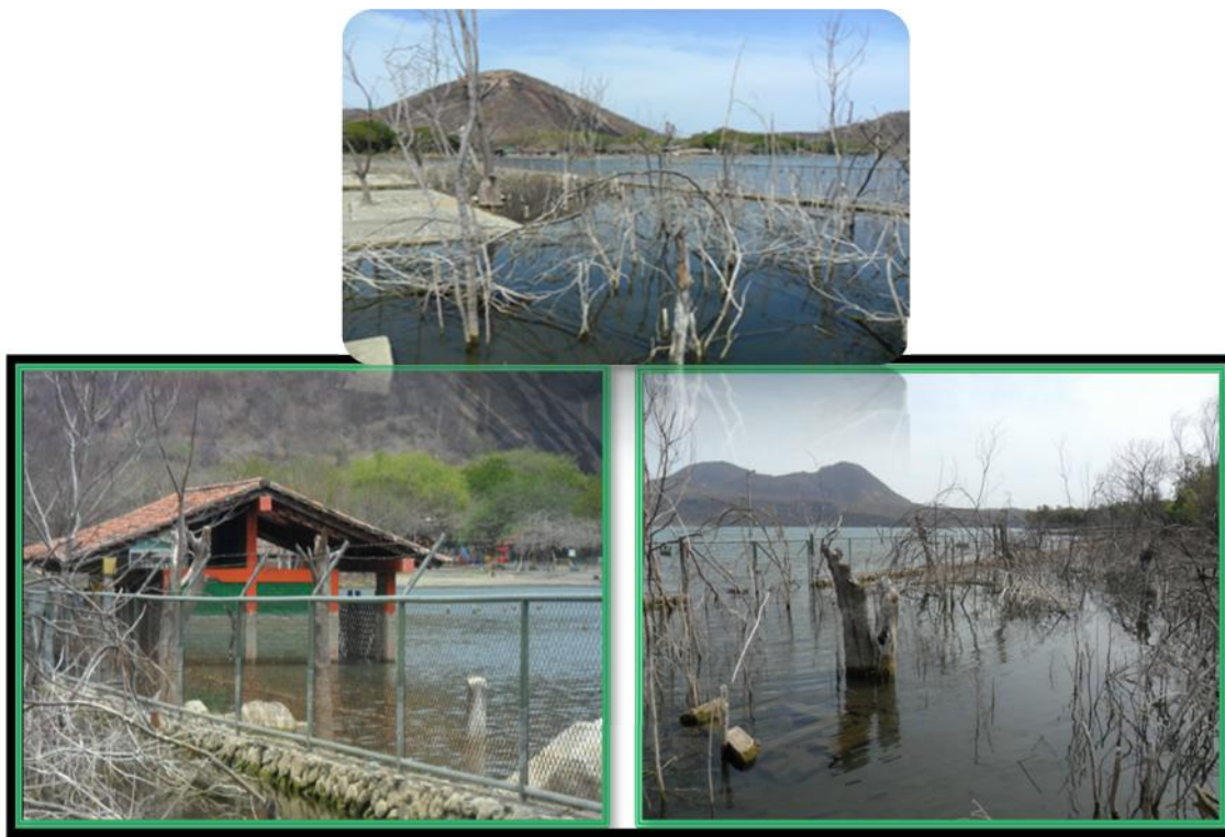
Ilustración 8, Zona del Centro Turístico, afectaciones por inundación provocada por la Laguna de Xiloá
