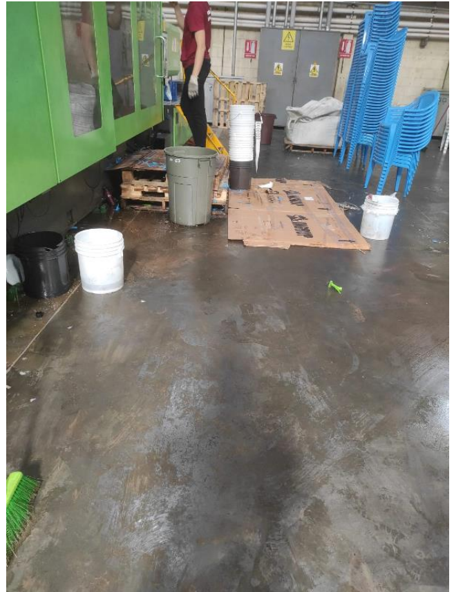
Ilustración 18 Peligro de caída al mismo nivel por piso con aceite
