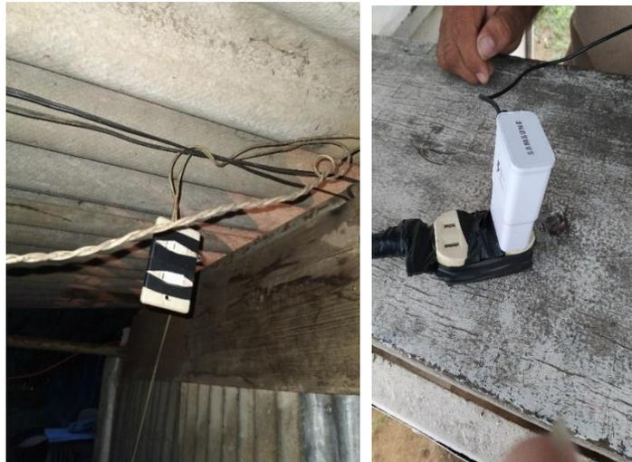
Presencia de conexiones inadecuadas, casetas se requieren mejorar las condiciones o activar las nuevas para que el trabajador agente de seguridad interna pueda cubrirse un poco de las condiciones ambientales.
