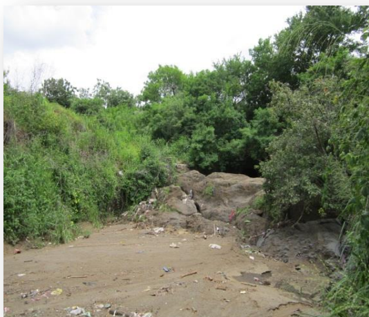
Foto No.17: Vista del lecho del cauce hacia el puente vehicular de la pista suburbana
