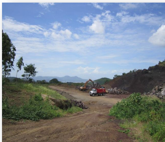
Foto No.23: Vista del área de la mina desde el camino de acceso principal
