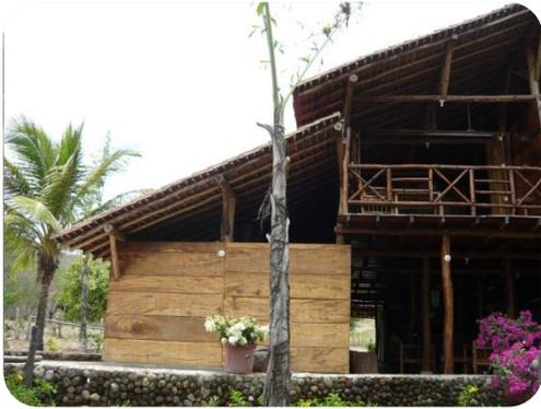
Este edificio posee deficiencia de confort acústico por varias razones. Las particiones de madera solo llegan hasta cierta altura y la estructura de techo queda descubierta. Esto provoca que el sonido del exterior se perciba entre ambientes adyacentes.
