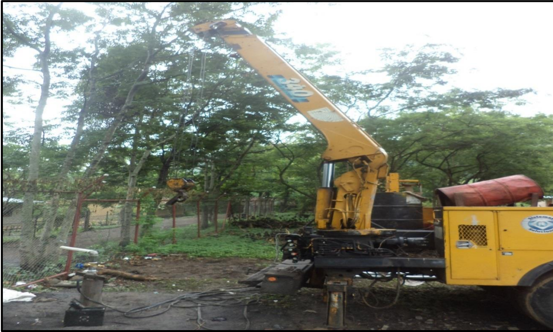
Imagen N°: 11, Aforo, perforacion de pozo.
