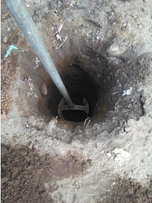
Figura 35: Excavación del sondeo
