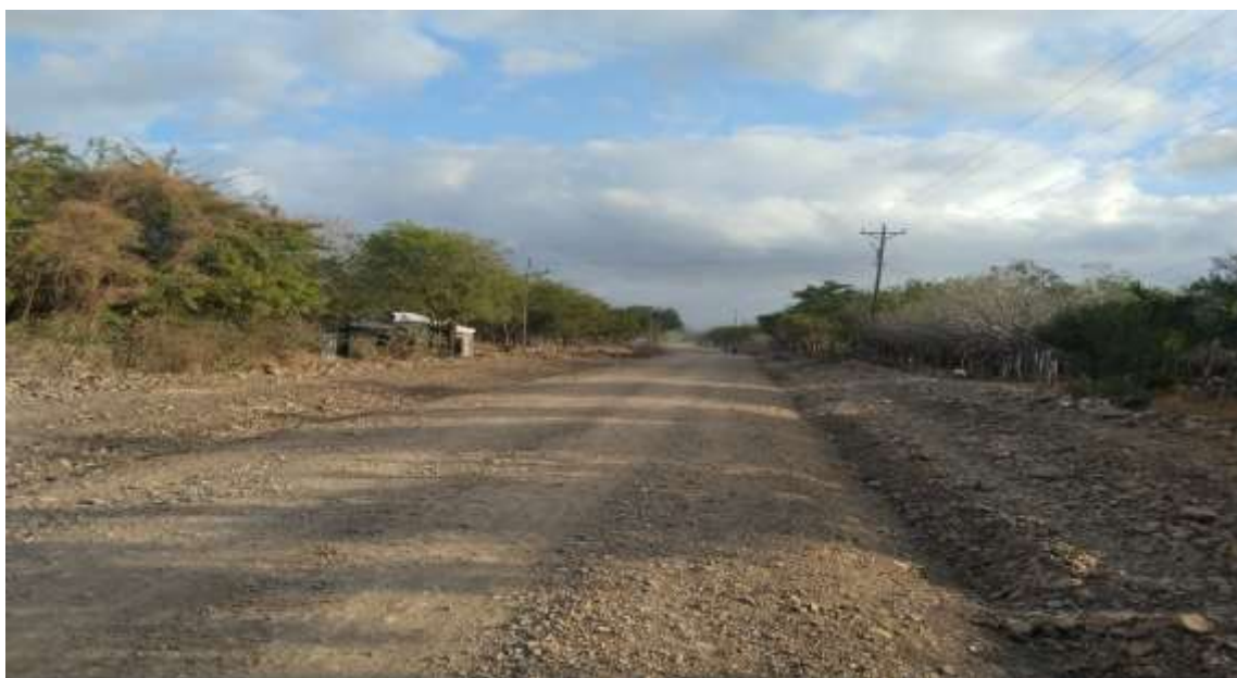
Imagen N° 20. Estación 2+500 final del tramo
