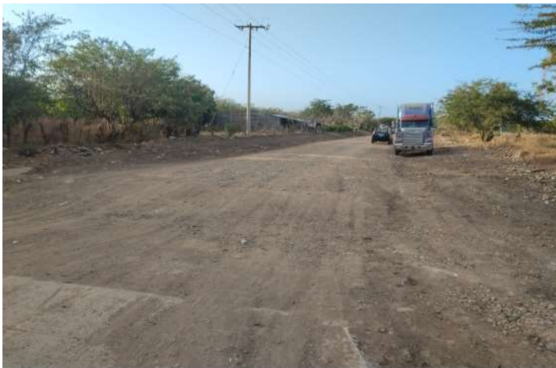
Imagen N° 19. Estación 0+000 inicio del tramo
