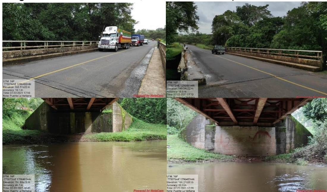
Figura 75. Puente La Verbena, ubicado en el municipio de Nueva Guinea
