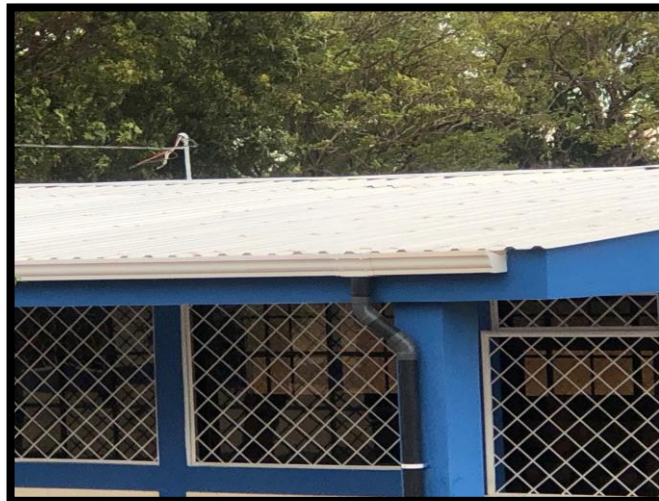
Figura 3. Cubierta del techo
