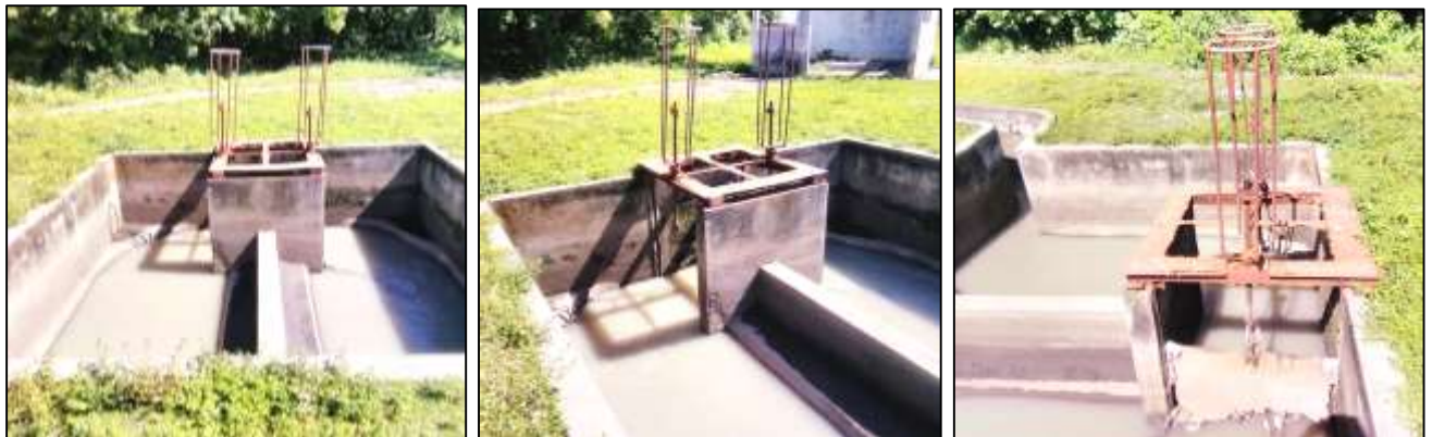
Imagen 3. Obra en el afluente de la PTAR
