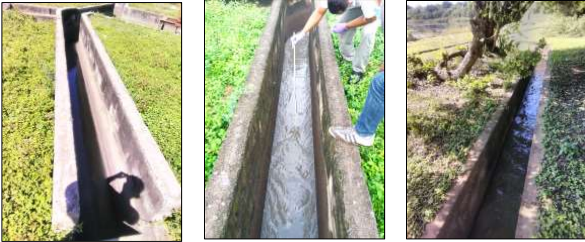
Imagen 4. Canal rectangular de entrada
