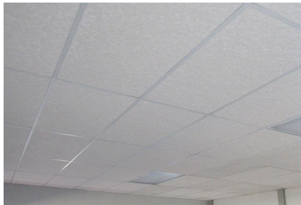
Ilustración N°29: Resultado final cielo falso
