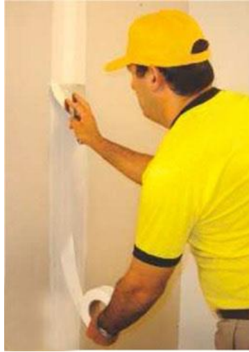
Ilustración N°24: Enmasillado.
