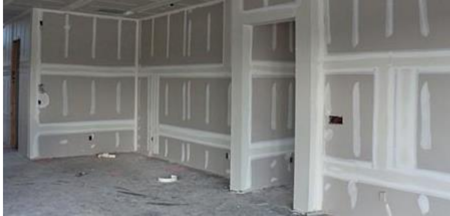
Ilustración N°25: Resultado final de Superficies lijadas Fuente: Google imágenes, foto con fines ilustrativos.
