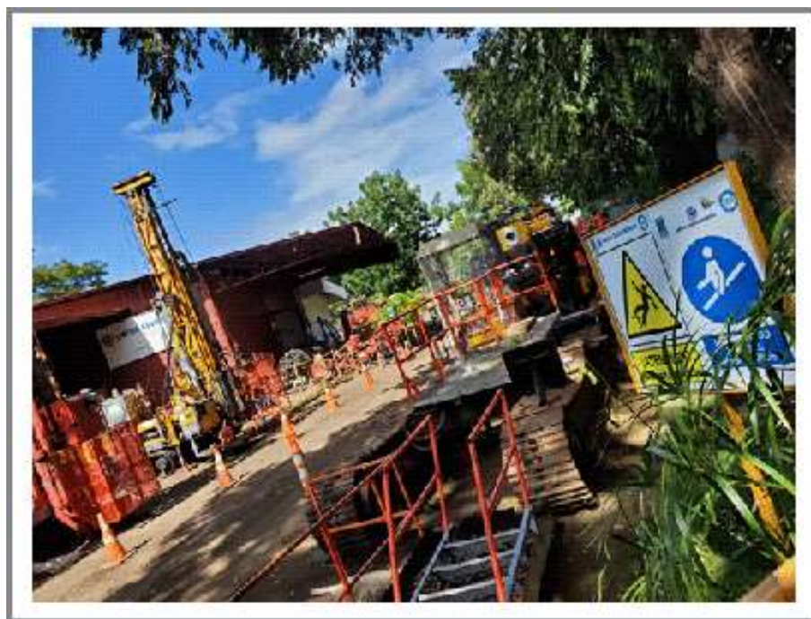
Anexo 3: patio lateral del taller de Rodio Swissboring Nicaragua
