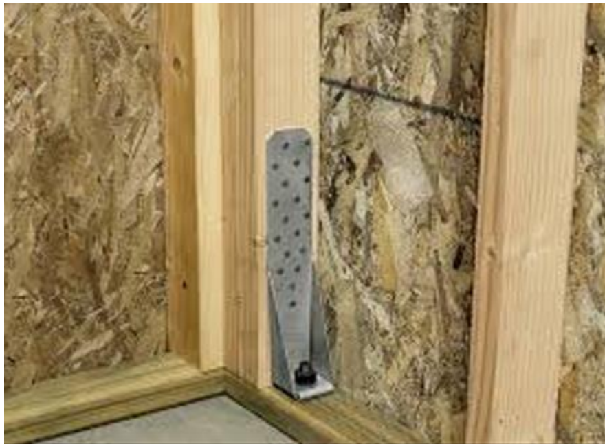
Figura 10 Aplicación de holddown en muros de corte
