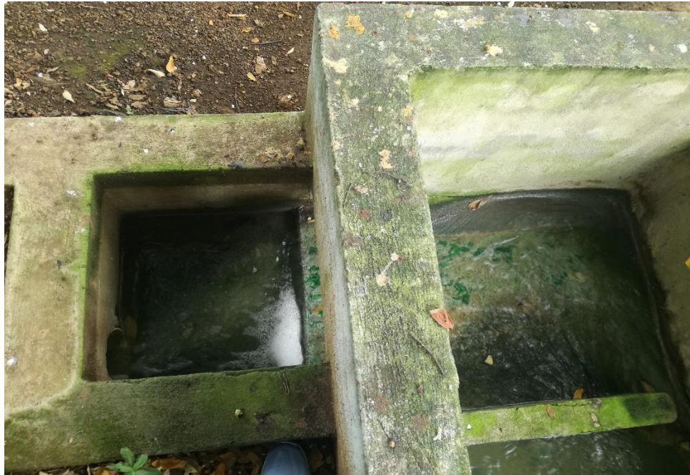
Detalle de salida del humedal
