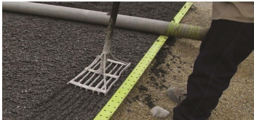
Figura 49. Compactación del concreto permeable en zonas frágiles.
