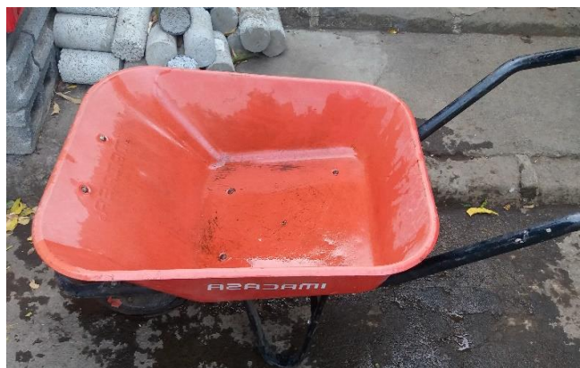
Figura 32. Preparación del recipiente para la fabricación del concreto permeable.
