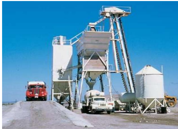
Figura 41. Traslado del concreto en camiones mezcladores.
