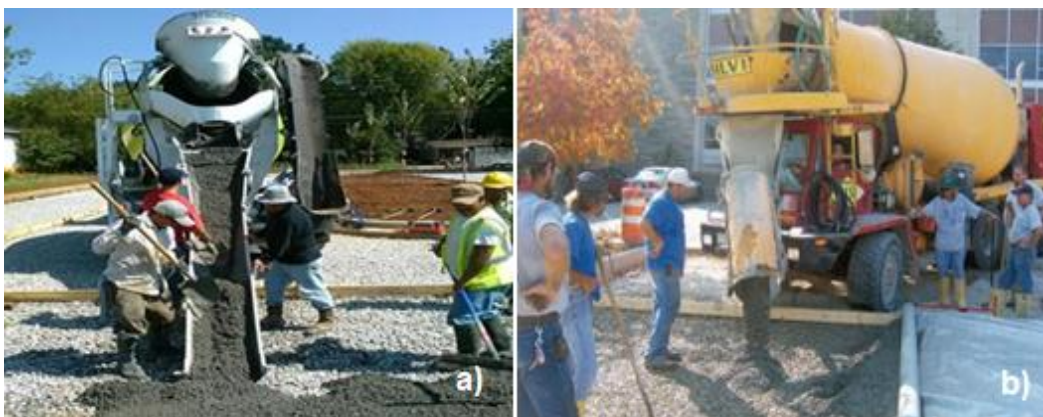
Figura 46. Descarga frontal y lateral del concreto permeable.
