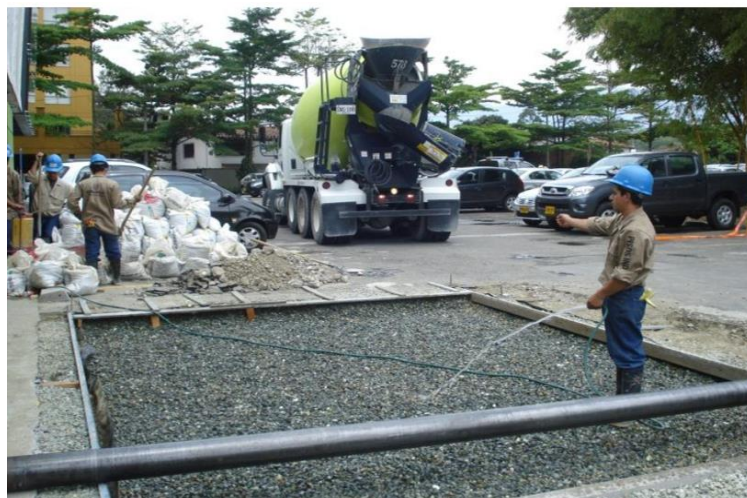
Figura 43. Humedecimiento de la base.
