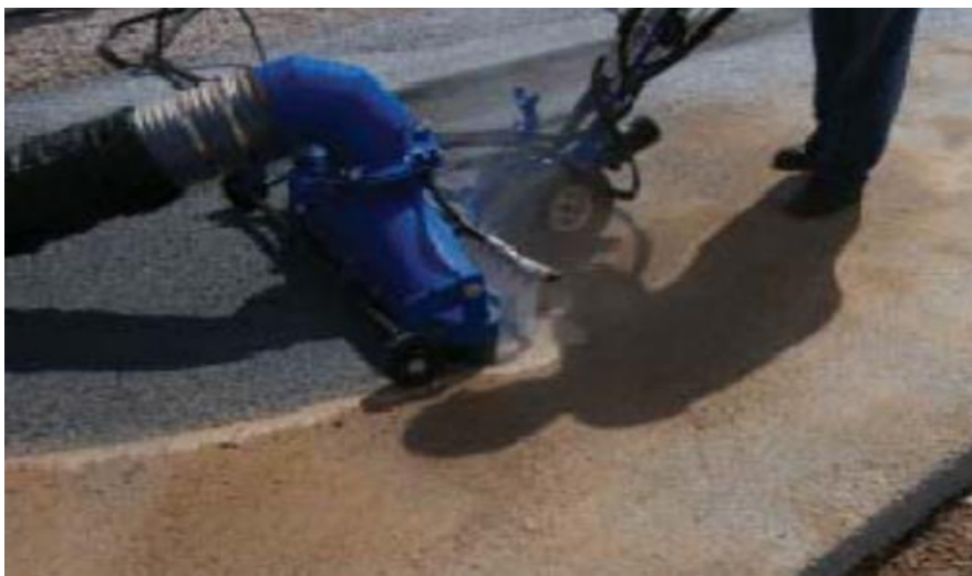
Figura 18. Mantenimiento de andenes peatonales de concreto permeable mediante aspirado.
