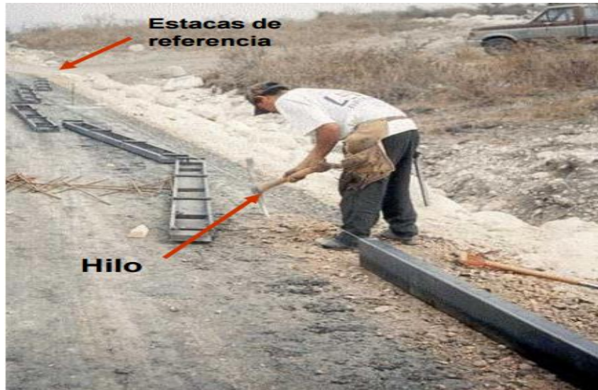
Figura 44. Colocación de formaletas en base granular.
