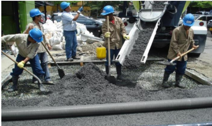
Figura 47. Colocación del concreto permeable.
