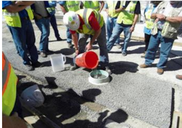
Figura 17. Prueba de infiltración del concreto permeable en campo según ASTM C1701.
