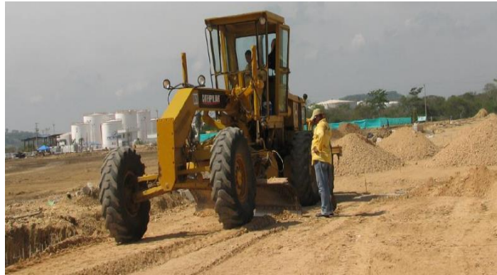
Figura 42. Movimiento de tierra en la preparación de la subrasante.
