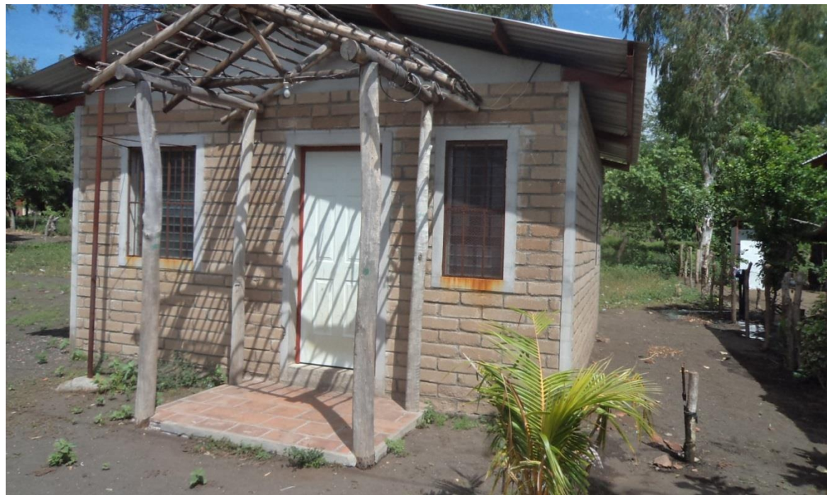
Erosión de material por falta de revestimiento
