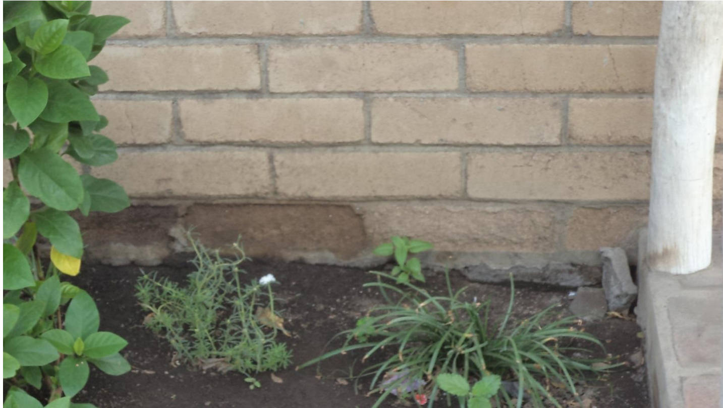
Erosión de material por falta de revestimiento
