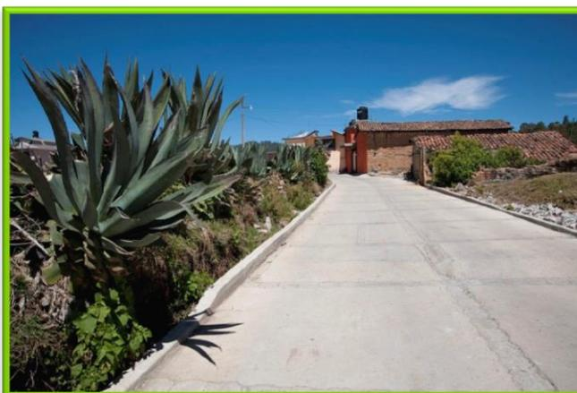
Imagen No 11 Carretera de concreto hidráulico
