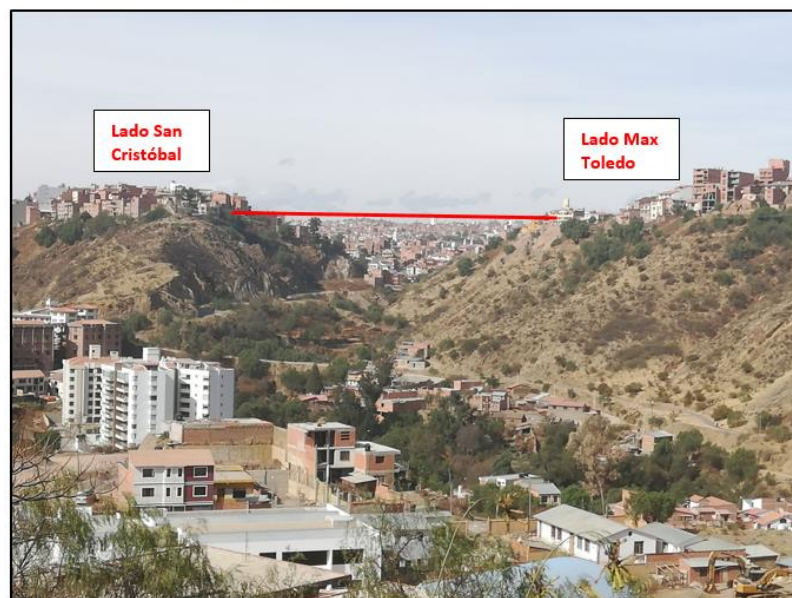
Figura 2. Emplazamiento del puente vista desde el lado oeste (aguas abajo).
