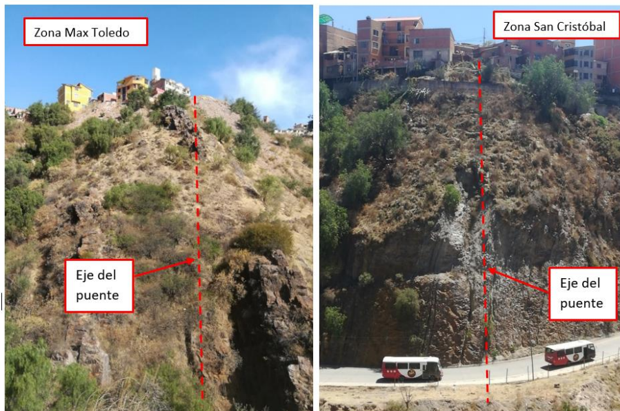
Foto 1. Suelo tipo roca fisurada lado Max Toledo.
