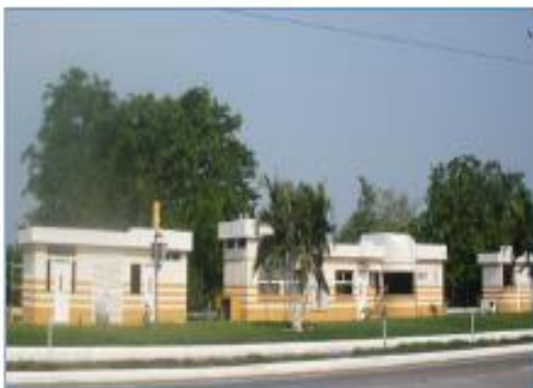
ESTACIÓN DE CONTROL, PUERTO QUETZAL, ESCUINTLA KM. 98+639 RUTA CA-9 SUR "A"
