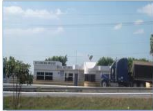
ESTACIÓN DE CONTROL, ESCUINTLA KM. 64+629 RUTA CA-9 SUR "A"
