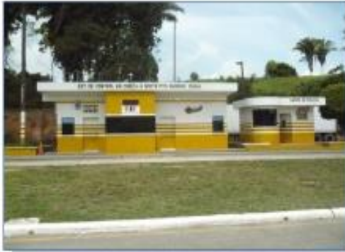
ESTACIÓN DE CONTROL, PUERTO BARRIOS, IZABAL, KM. 288 RUTA CA-9 NORTE
