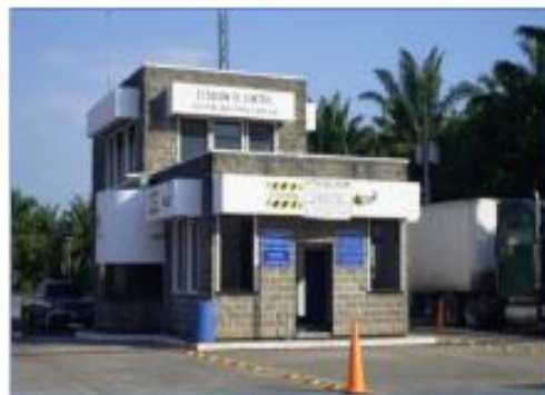
ESTACIÓN DE CONTROL, TECÚN UMÁN, SAN MARCOS KM. 250, BIFURCACIÓN CA-2 OCCIDENTE "A"
