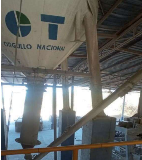
Fotografía 4: Silo de cemento
