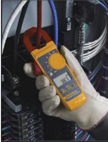
Figura 12. Medición de intensidad (amperaje). (Fuente propia)
