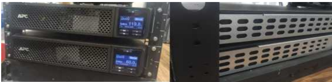
Ilustración 19: Instalación de Baterías de respaldo APS
