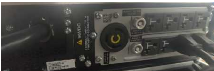
Ilustración 22: Conexión de servidores en baterías
