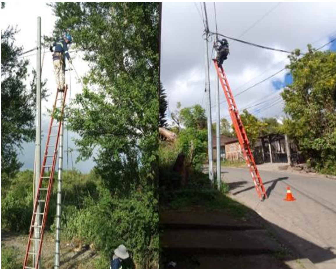
Figura 48: Instalación de fibra.
