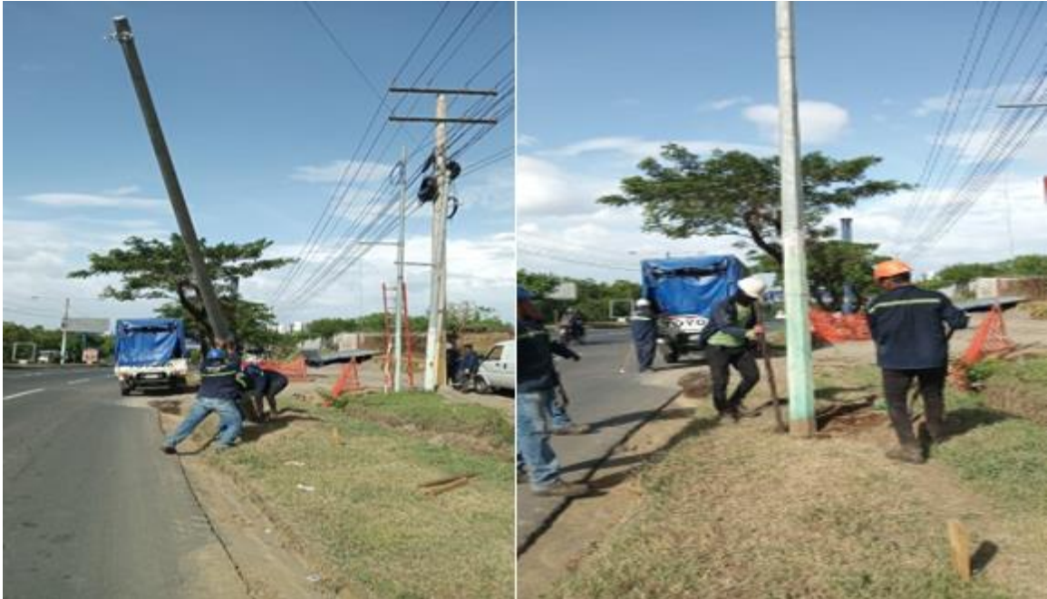
Figura 46: Instalación de poste.
