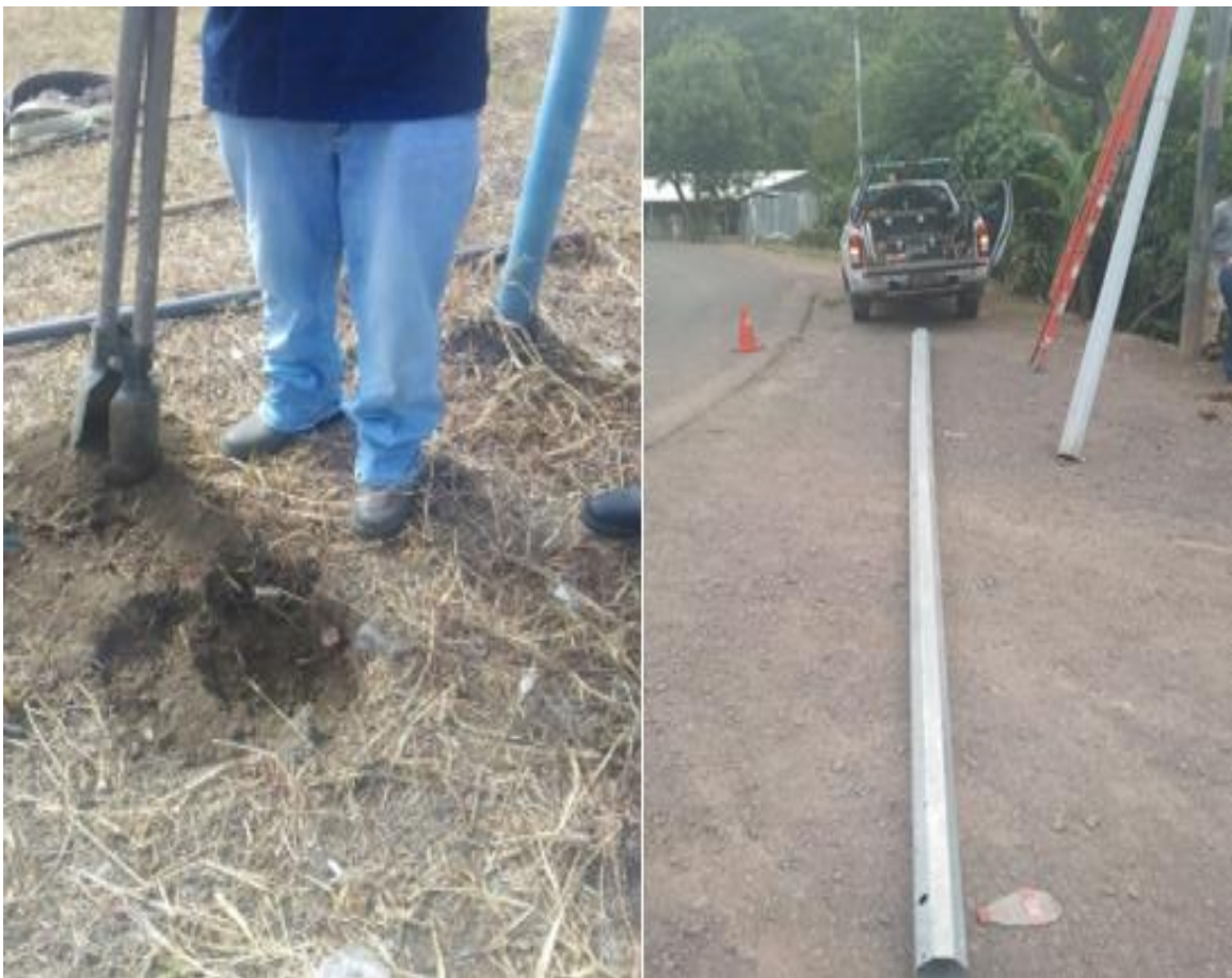
Figura 45: Instalacion de postes.
