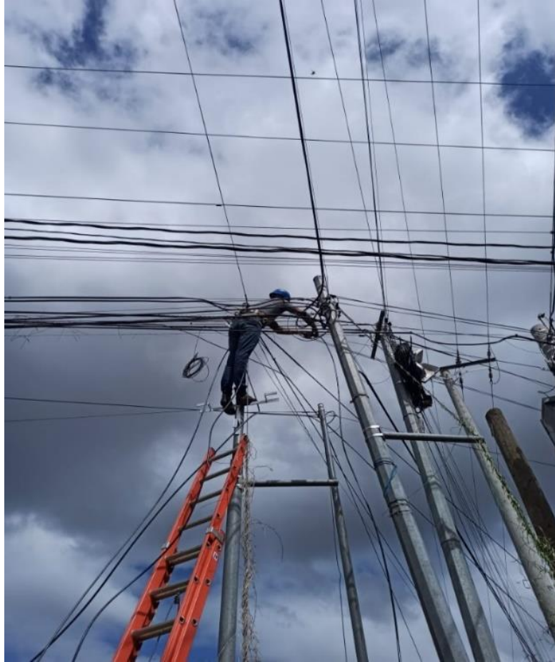
Figura 49: Instalación de fibra.
